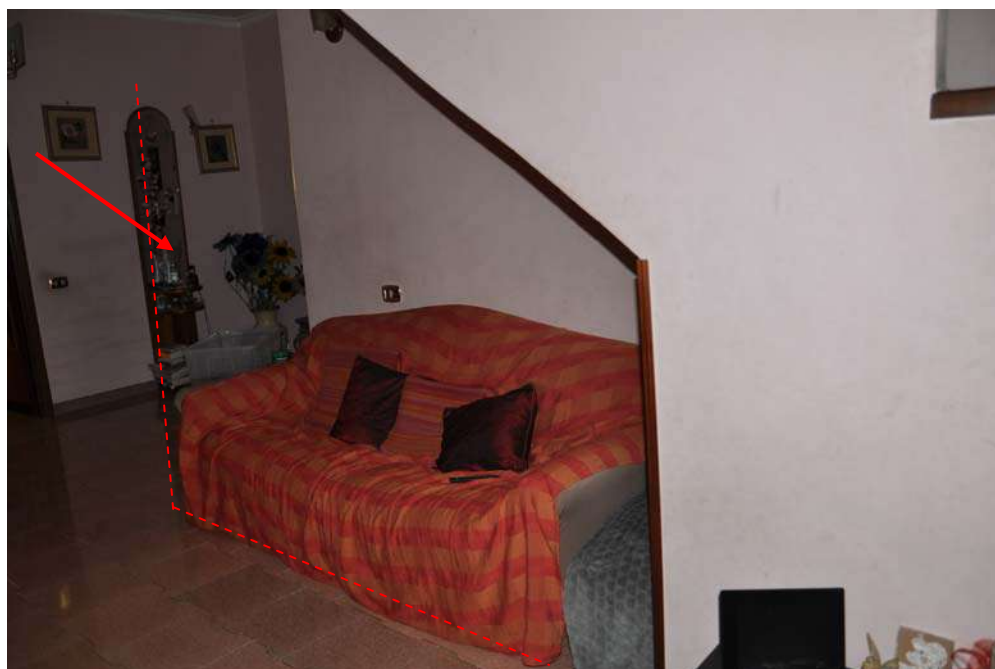
Rimozione del ripostiglio nel sottoscala
