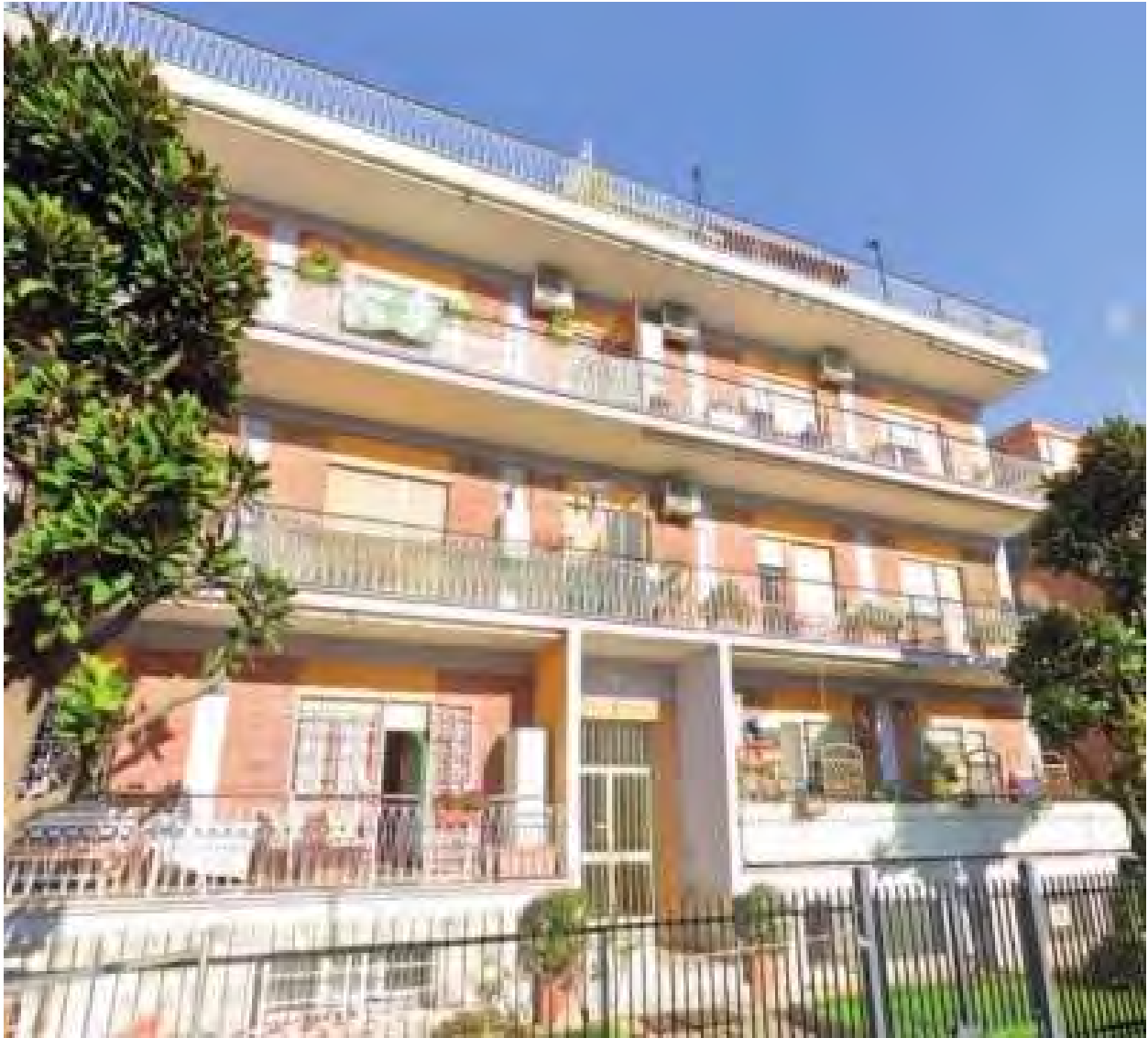
Prospetto edificio lato ingresso in Via Giuseppe Bellucci, 38
