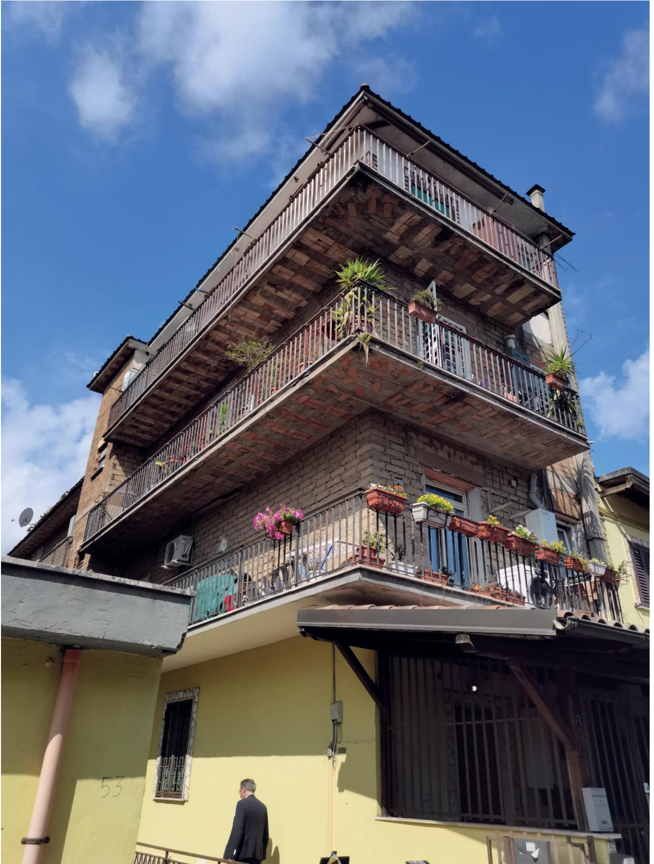
Il fabbricato visto da Via Valguarnera Caropepe
