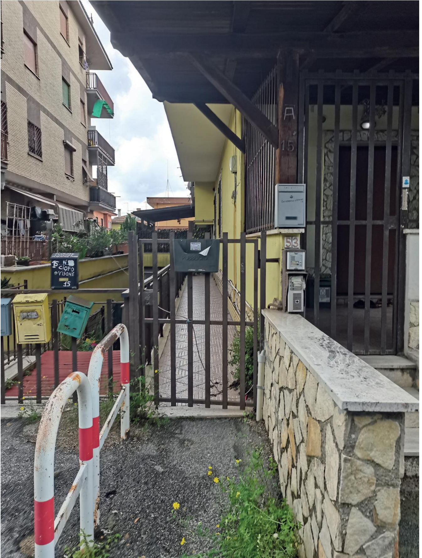
Ingresso laterale del fabbricato da Via Valguarnera Caropepe, 15
