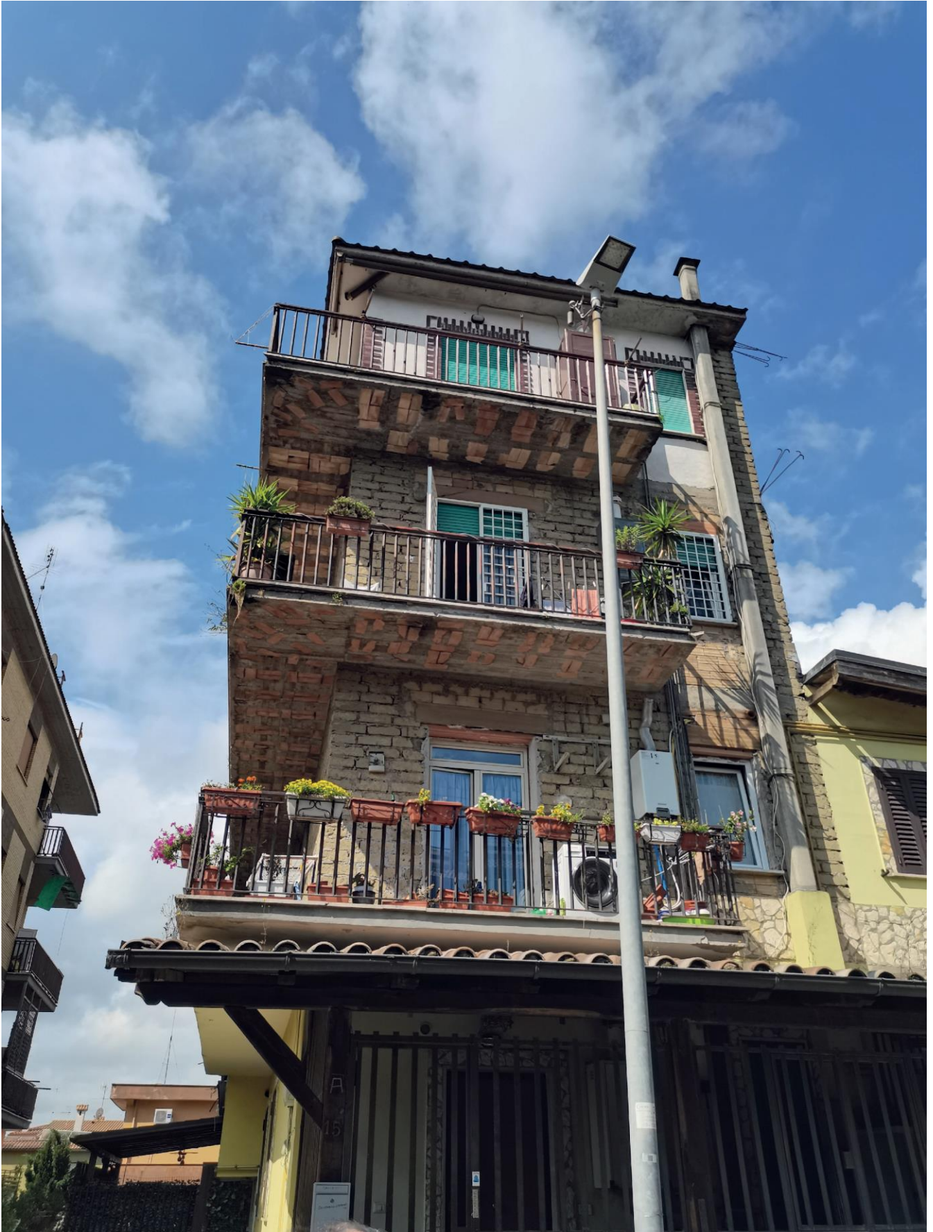
Il fabbricato visto da Via Valguarnera Caropepe
