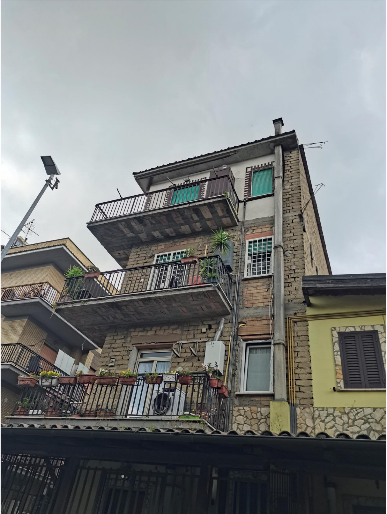
Il fabbricato visto da Via Valguarnera Caropepe
