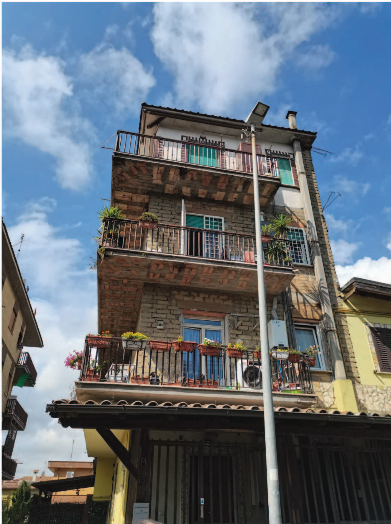
Il fabbricato visto da Via Valguarnera Caropepe
