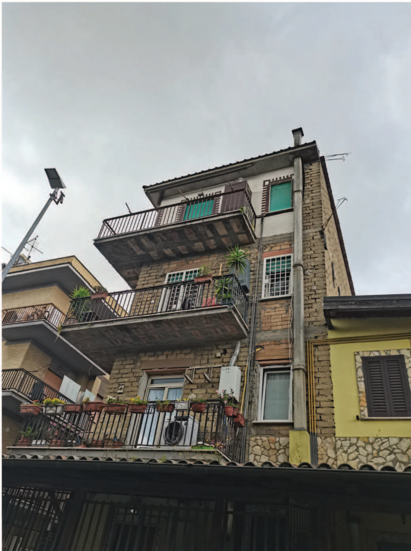
Il fabbricato visto da Via Valguarnera Caropepe
