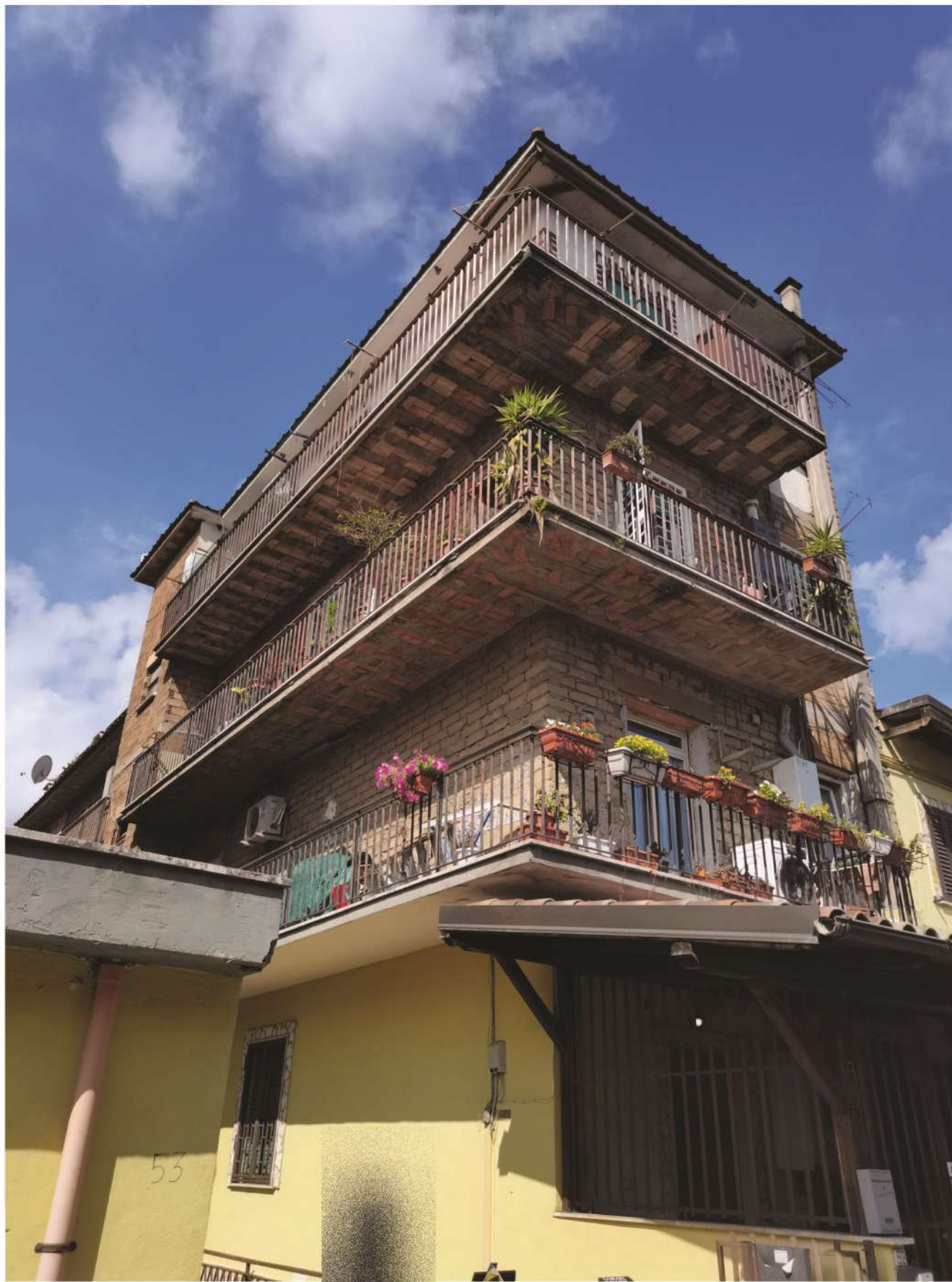
Il fabbricato visto da Via Valguarnera Caropepe
