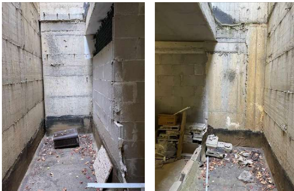
La porzione di intercapedine di fatto annessa al box
