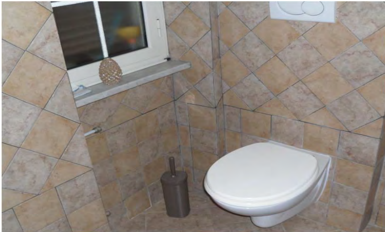
(FOTO INTERNA - BAGNO)
