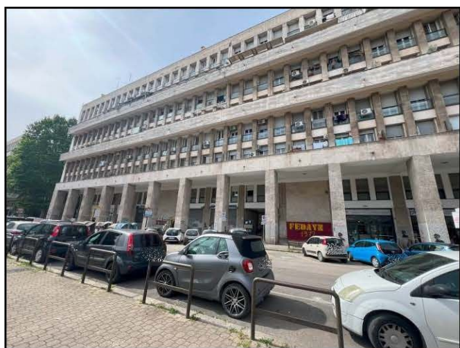
Vista del fabbricato su P.zza S. Giovanni Bosco 74
