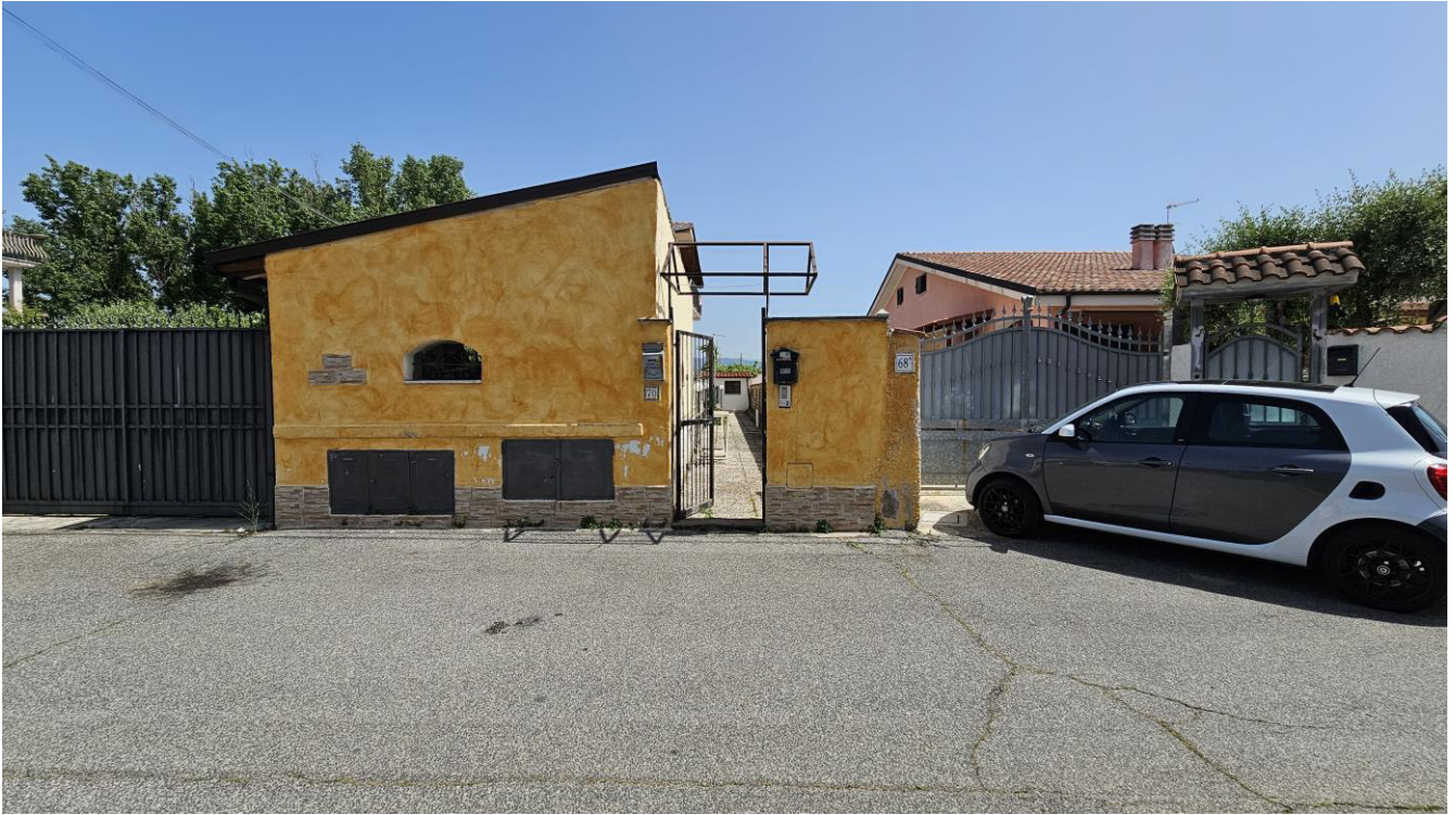
Accesso da Via Agugliano – si accede all'appartamento tramite stradello condominiale
