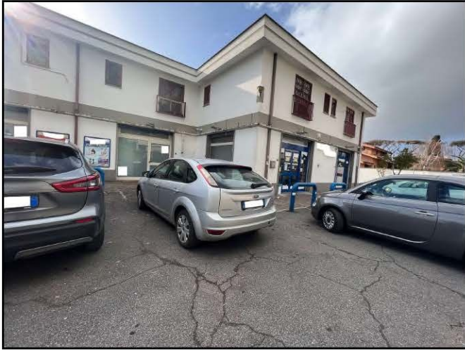
Vista dell'accesso su Via Salerno n. 20
