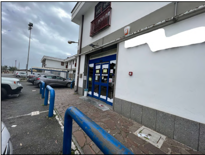
Vista dell'accesso su Via Salorno n. 18
