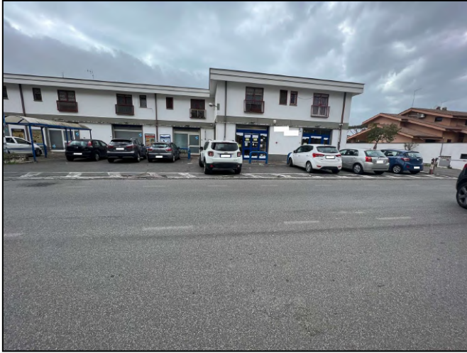
Vista esterna dell'immobile su Via Salorno
