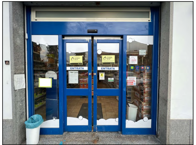
Vista dell'accesso su Via Salorno n. 18
