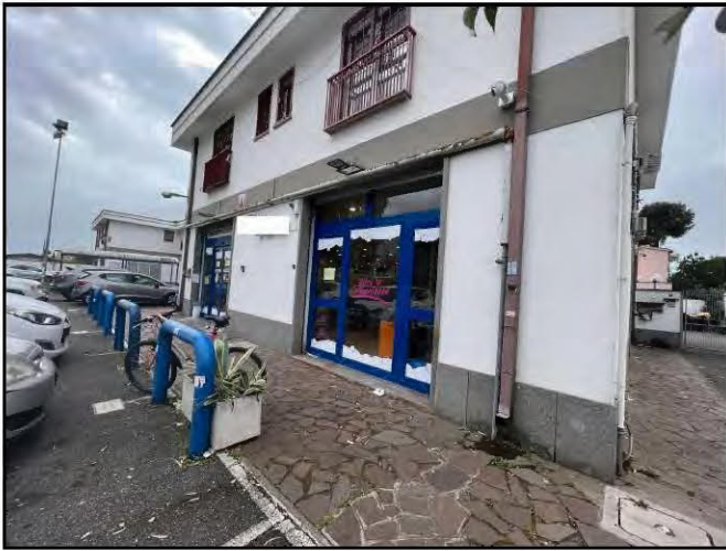
Vista dell'accesso su Via Salerno n. 16
