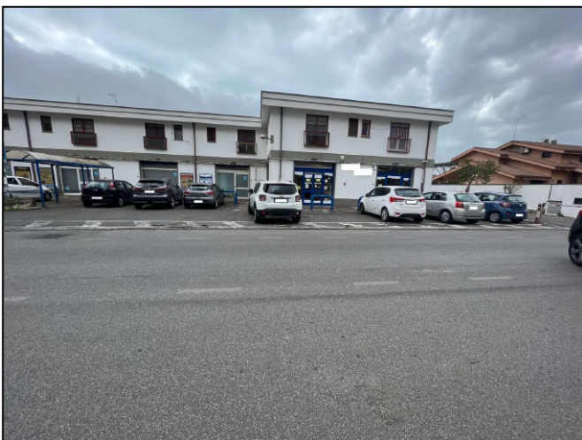
Vista esterna dell'immobile su Via Salorno
