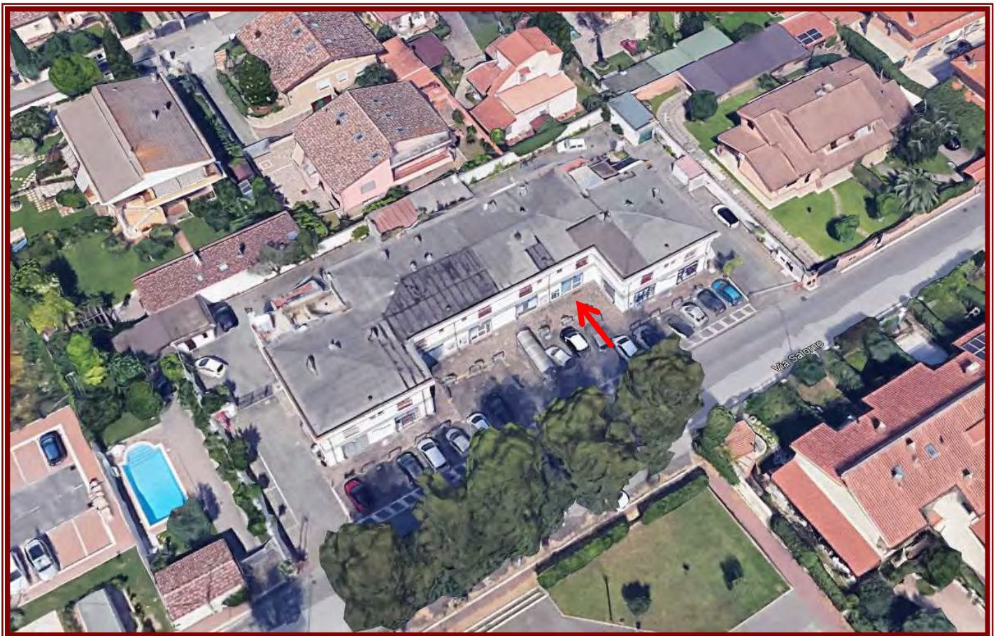
Vista 3D da Google Earth – Vista dell'accesso al locale commerciale posto su Via Salerno n. 20
