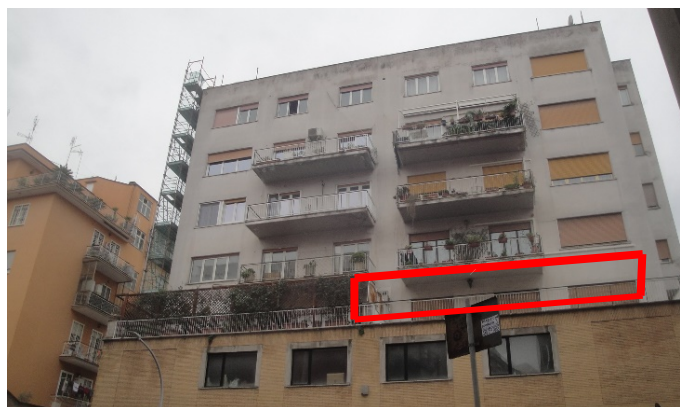
Via Francesco Catel n. 35 -Viste dell'edificio
