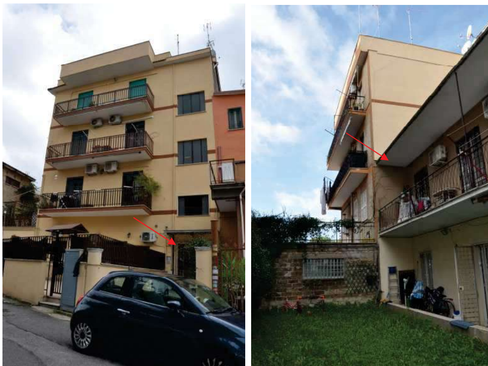
Ingresso all'edificio - fabbricato in esame
