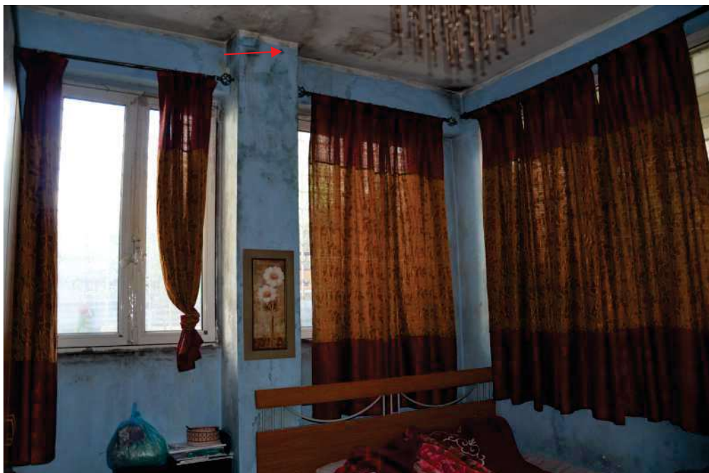
Muro nella camera (volume aggiunto)
