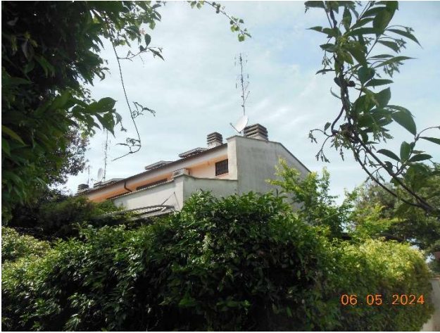
Vista impianto solare sulla copertura
