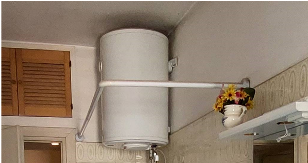
Lo scaldabagno elettrico
