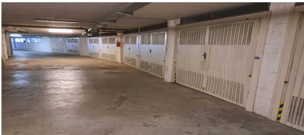
(CORSIA DEI BOX AUTO POSTI AL PIANO S1)
