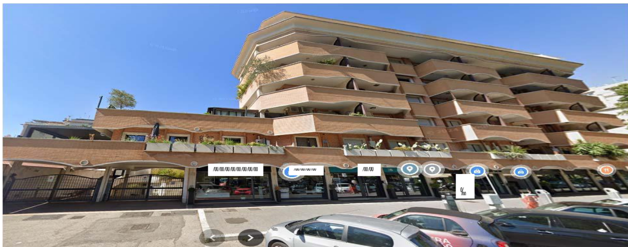
(VISTA D'INSIEME DELL'EDIFICIO DEL QUALE SONO PARTE LE 14 UNITA' IMMOBILIARI OGGETTO DI PIGNORAMENTO
