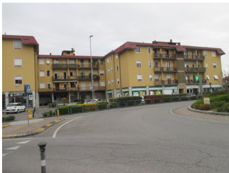
Vista da via Bergamo
