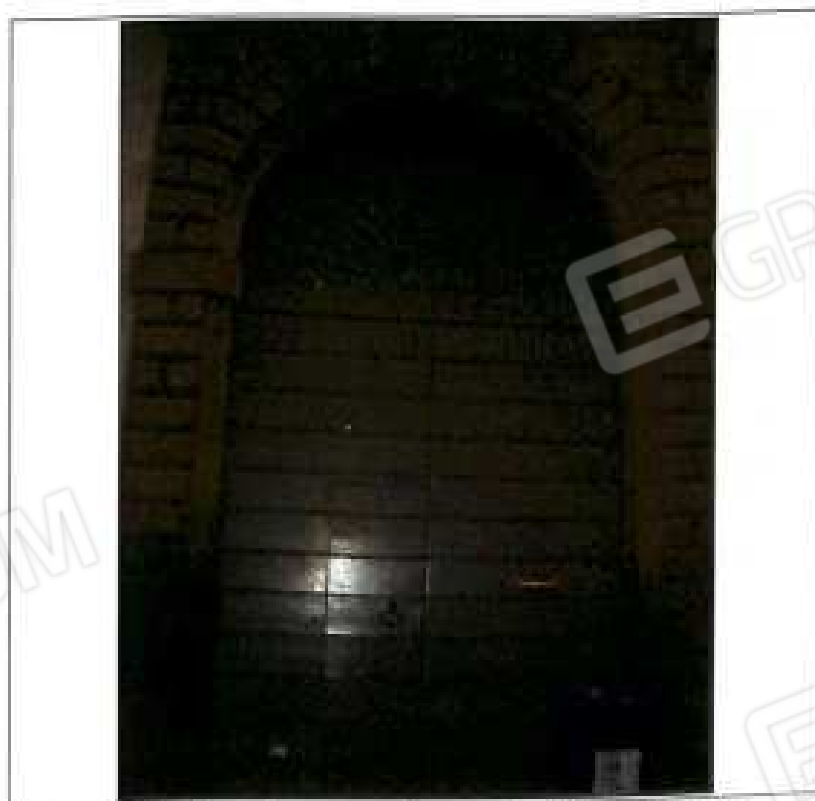
02 - Via salvecchio, portone di accesso al cortile condominiale
