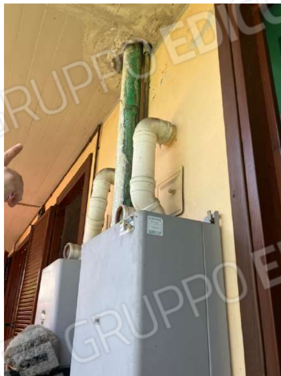
Foto n. 12 | Vista della facciata posteriore con evidenti infiltrazioni provenienti dal balcone del piano superiore che hanno provocato diffusi distacchi della tinteggiatura e dell'intonaco.
