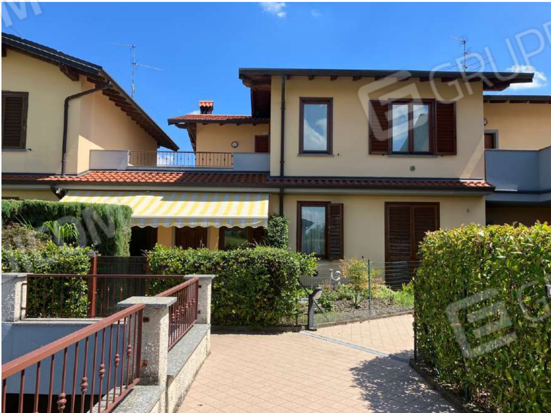
Foto n. 4 | Vista generale dell'edificio con al Piano Terra l'appartamento oggetto della presente procedura di esecuzione immobiliare.
