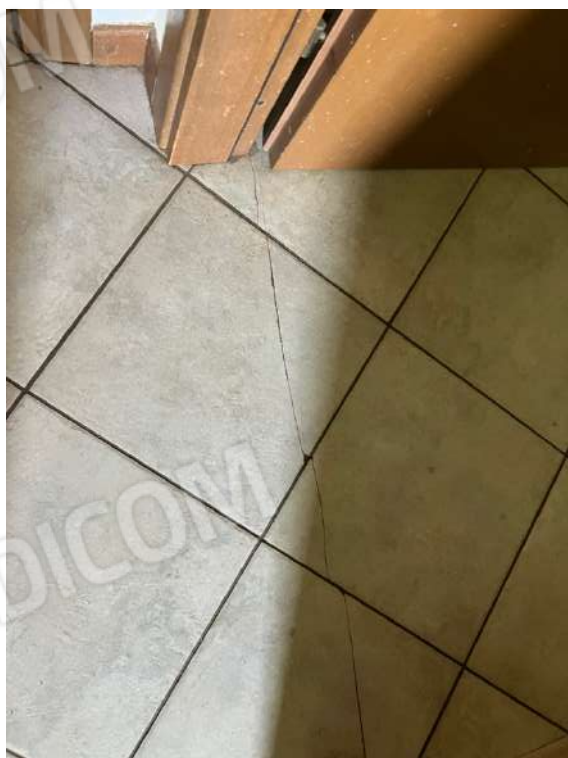
Foto n. 10 | Dettaglio delle crepe nella pavimentazione in ceramica del disimpegno.
