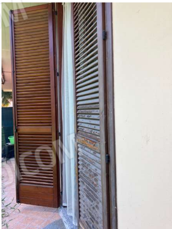
Foto n. 14 | La vernice scrostata sulle persiane.
