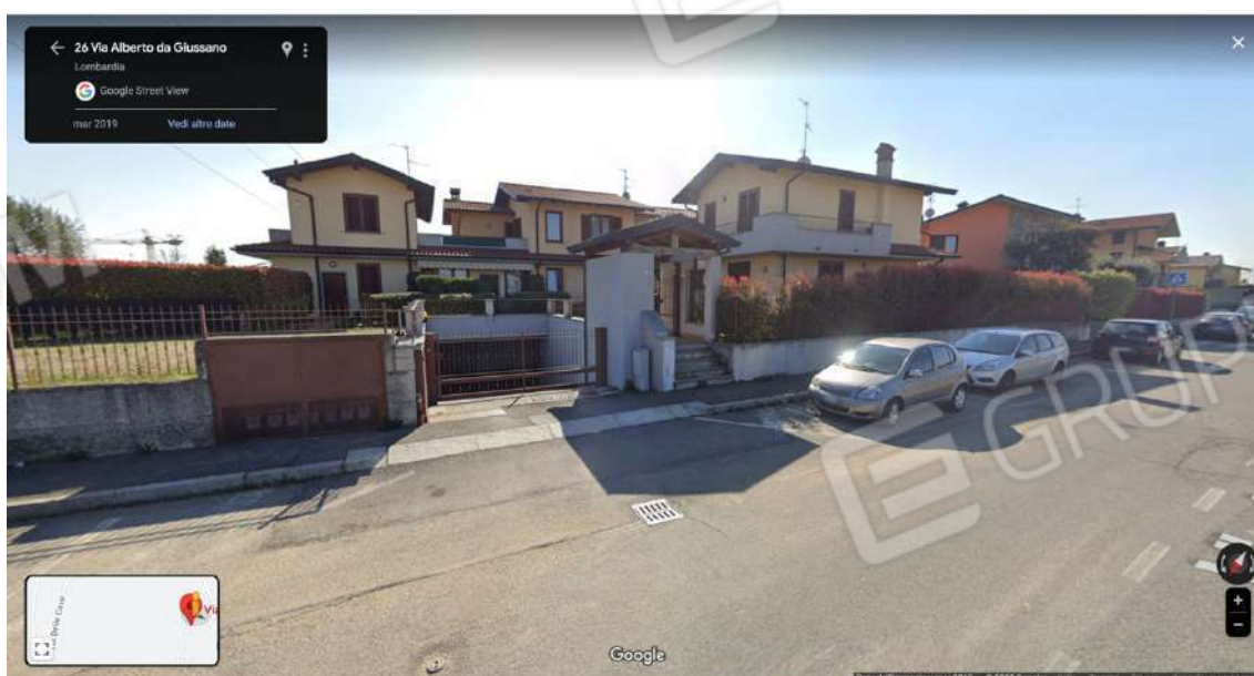
Foto n. 2 | Vista generale del complesso residenziale dalla strada Alberto da Giussano civico 26.
