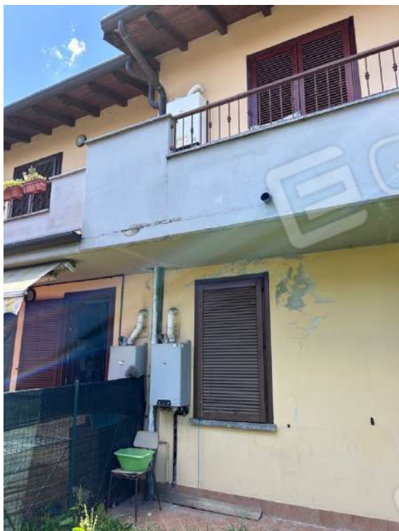
Foto n. 12 | Vista della facciata posteriore con evidenti infiltrazioni provenienti dal balcone del piano superiore che hanno provocato diffusi distacchi della tinteggiatura e dell'intonaco.
