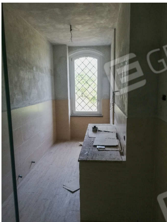
VISTA 39 – appartamento piano T
