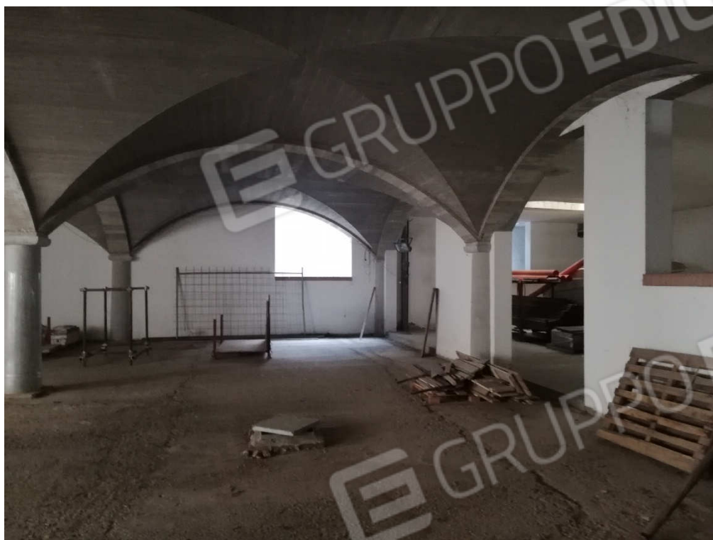
VISTA 23 – interrato capannone
