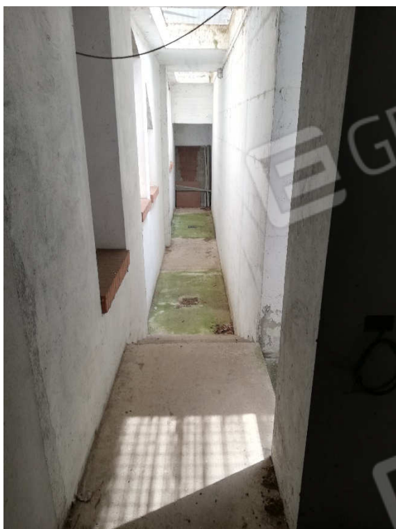
VISTA 16 – interrato uffici
