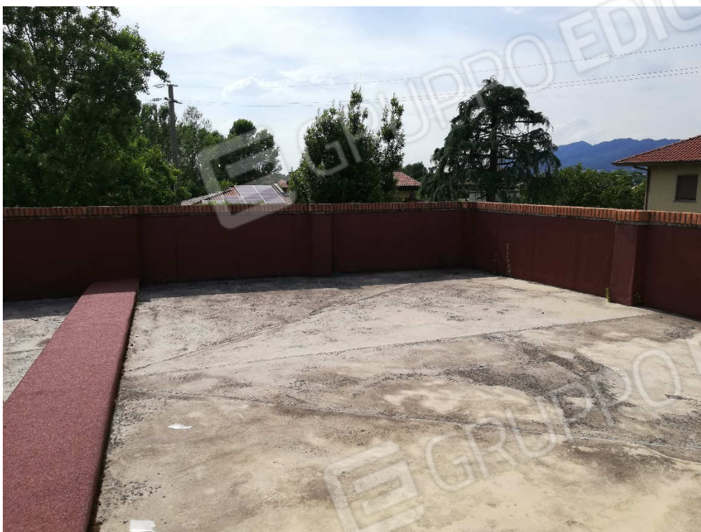
VISTA 65 – copertura uffici
