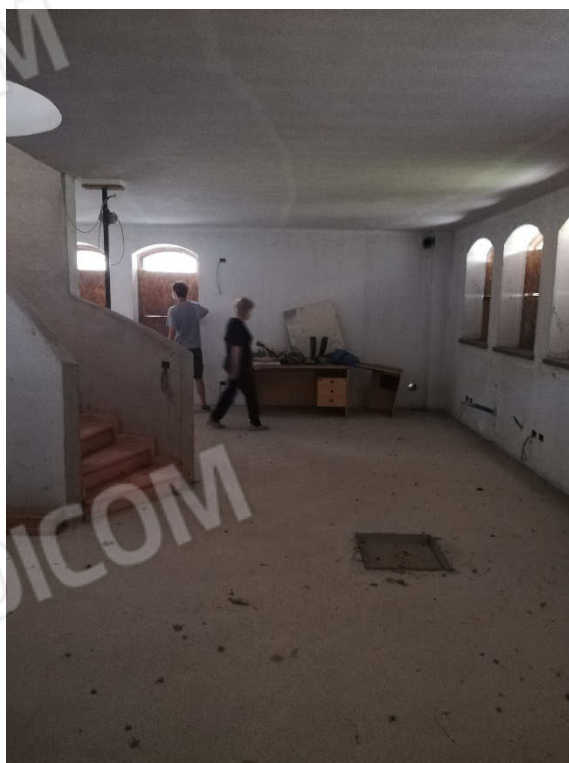
VISTA 14 – interrato uffici
