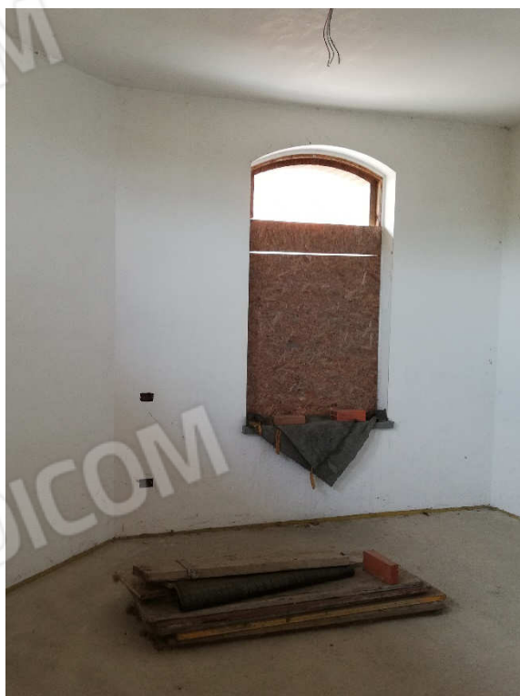
VISTA 51 – appartamento piano 1°
