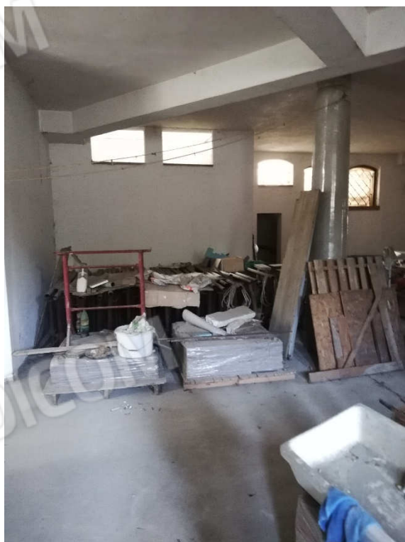
VISTA 31 – interrato appartamento
