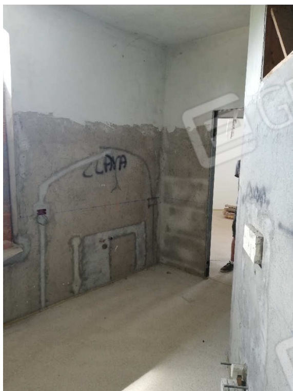
VISTA 53 – appartamento piano 1°
