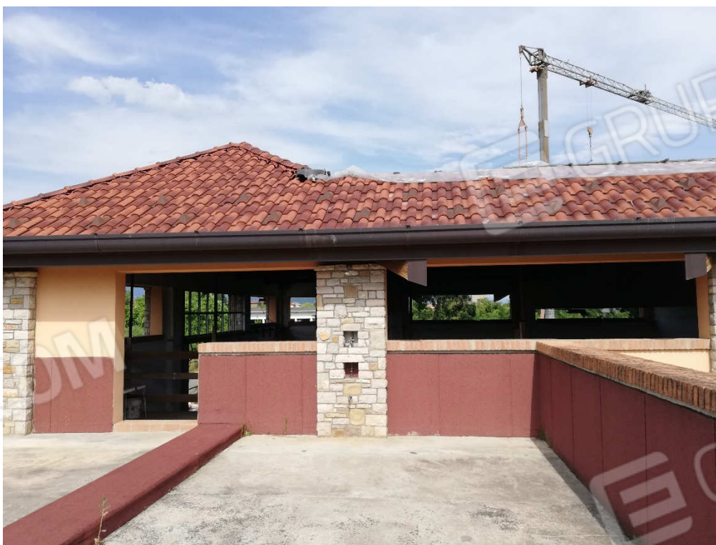
VISTA 66 – copertura uffici
