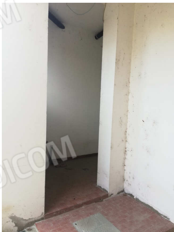
VISTA 27 – interrato appartamento
