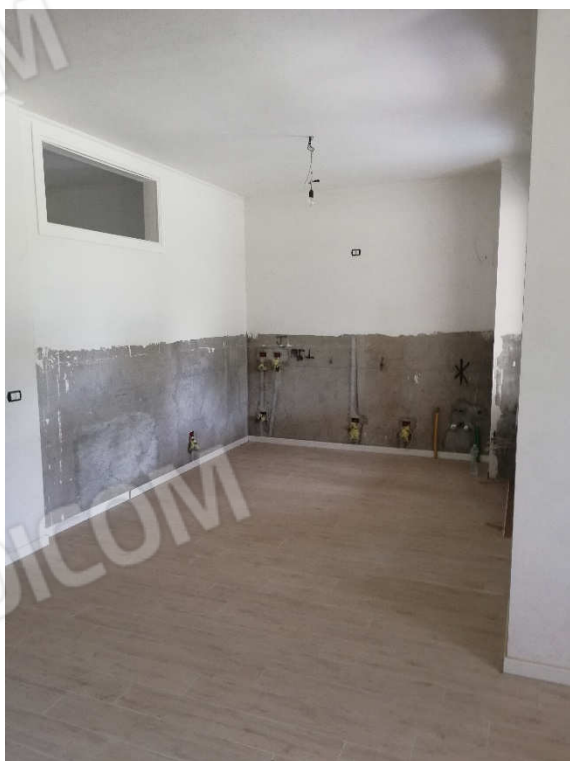
VISTA 37 – appartamento piano T
