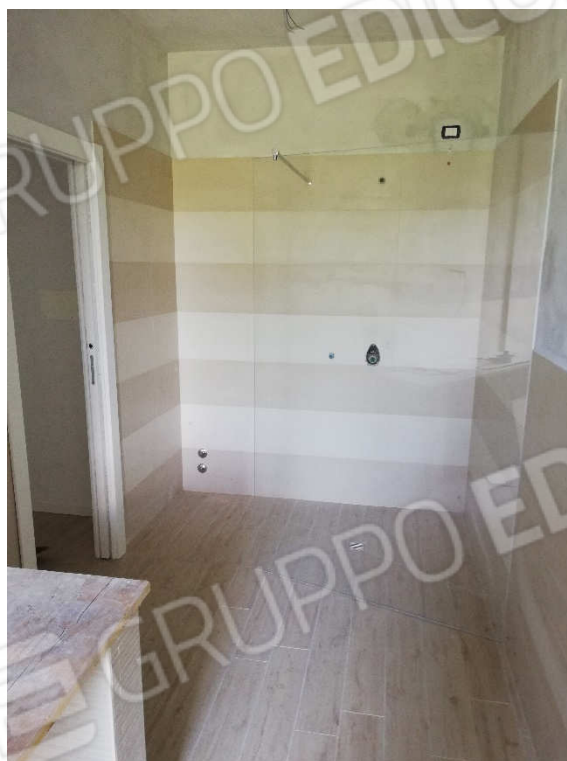
VISTA 40 – appartamento piano T
