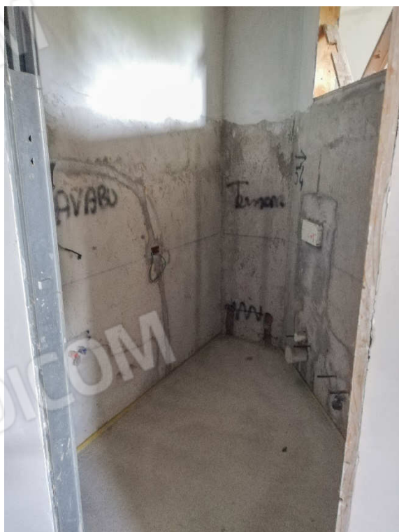
VISTA 55 – appartamento piano 1°
