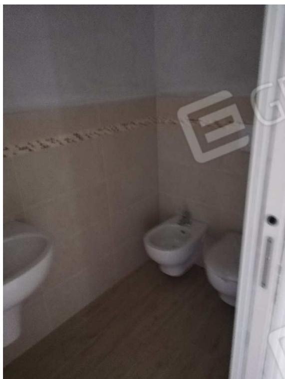
VISTA 43 – appartamento piano T
