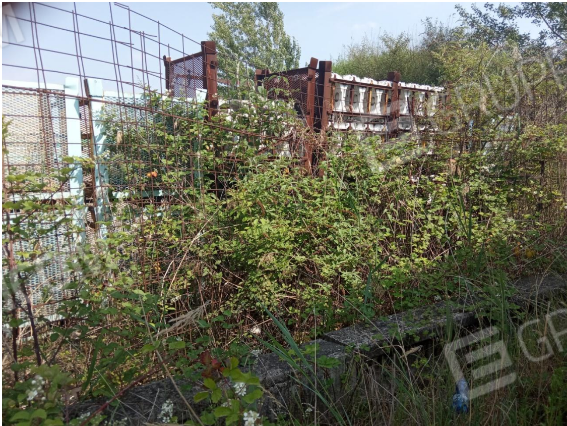
Rete metallica da demolire per formare il nuovo accesso
