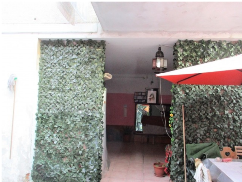
PORZIONE DI PORTICO DI ACCESSO ALLA SCALA
