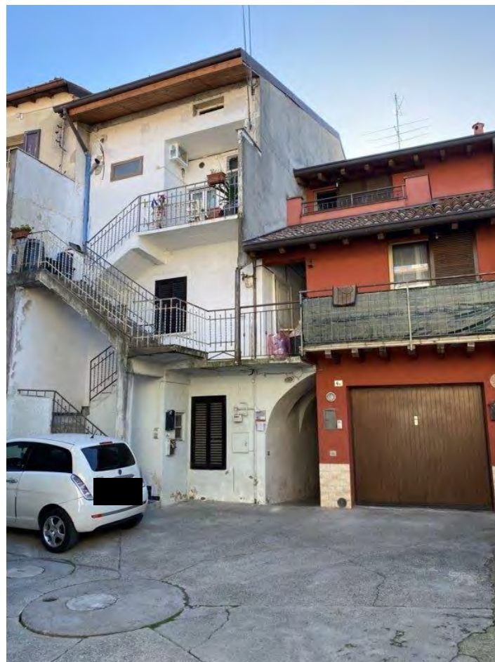
2 Il fabbricato bianco del mappale 891 con le scale esterne sul cortile
