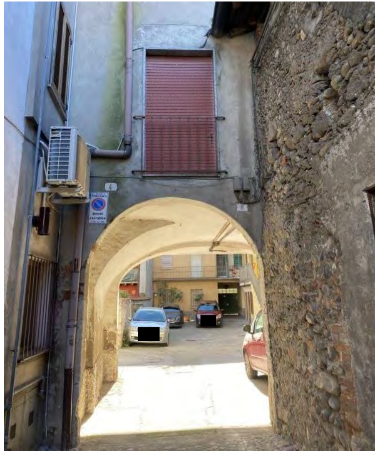
1 Passaggio coperto di accesso al cortile da vicolo Consoli
