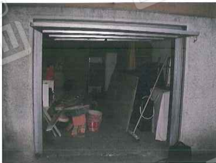
Foto 7 – dettaglio locale magazzino sub. 34
