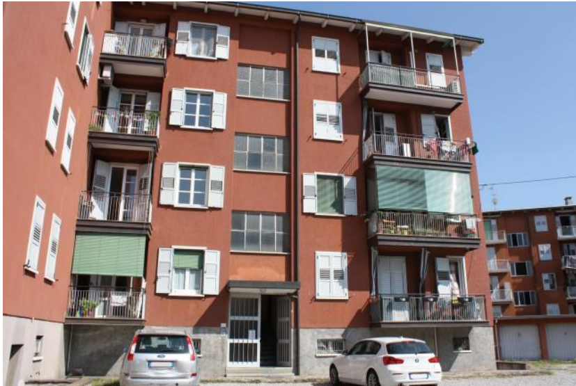
Vista esterna - fronte ovest
