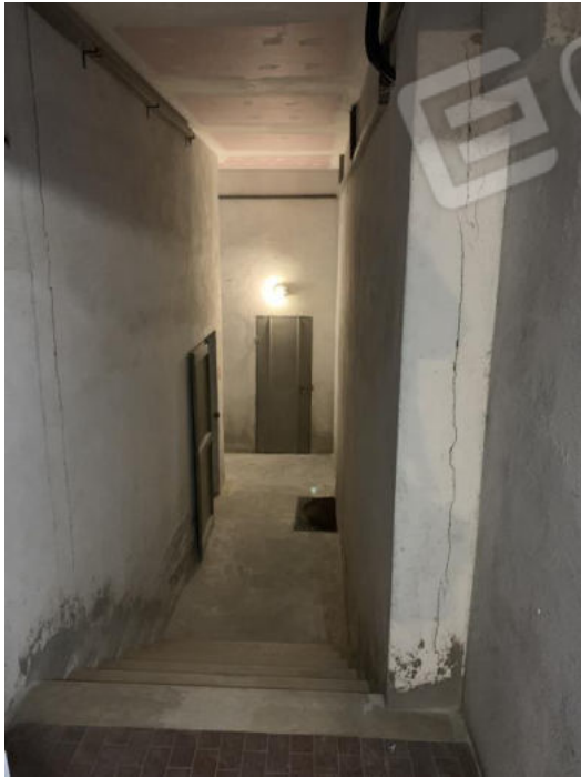
Disimpegno e porta accesso alla cantina
