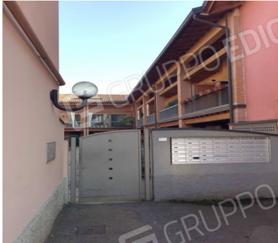
Ingresso da Via Mentana
