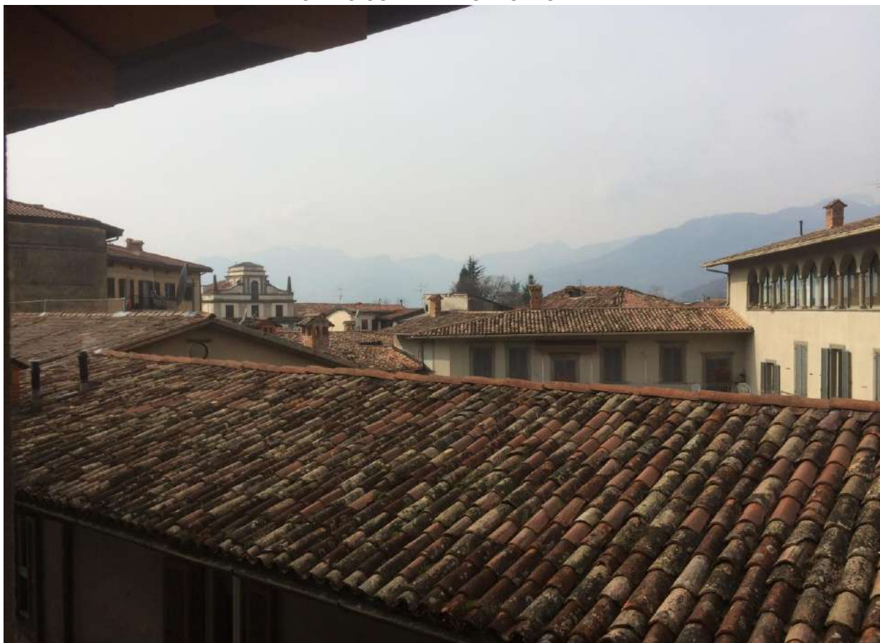
FOTO N. 27 – VISTA PIANO SECONDO lato via Gian Battista Castello
