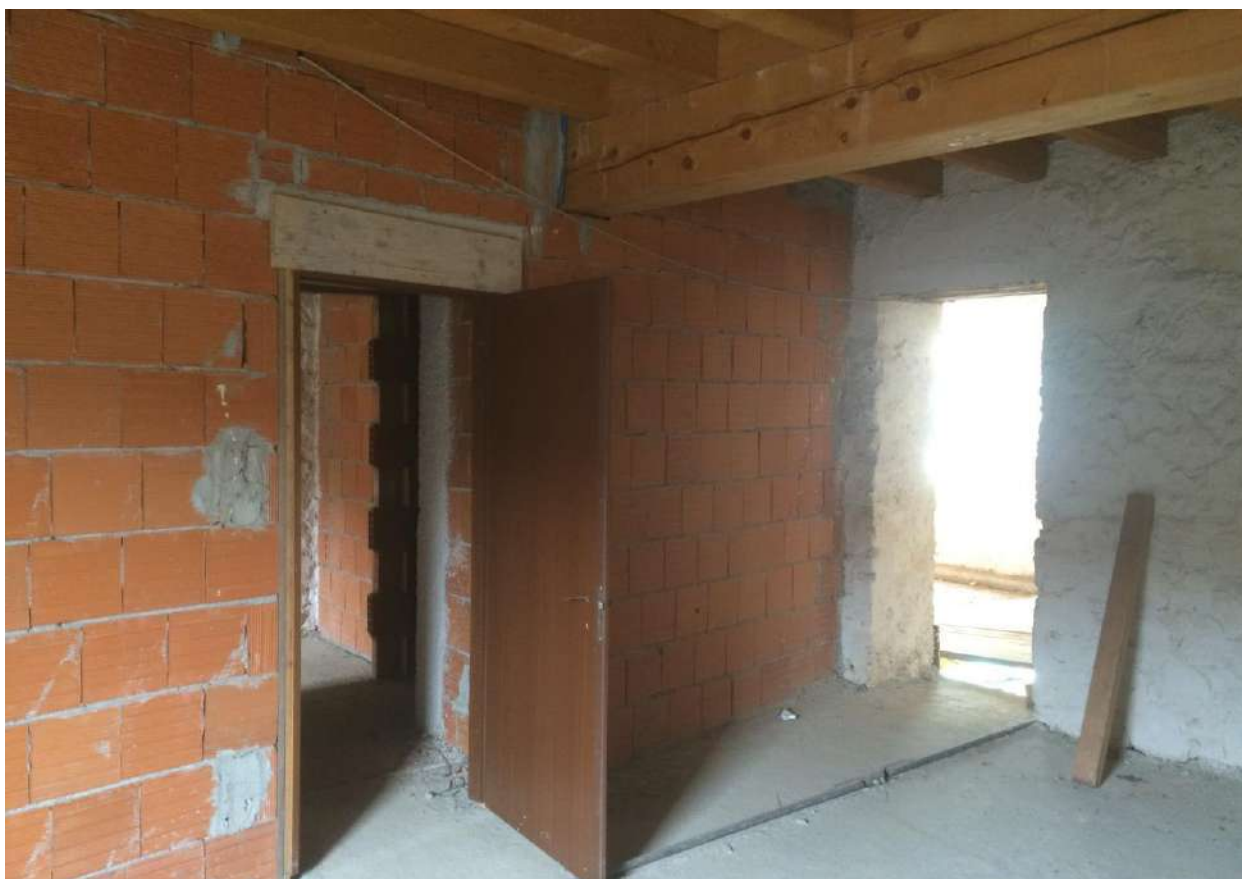
FOTO N. 20- LOCALE PIANO PRIMO pareti divisorie interne
