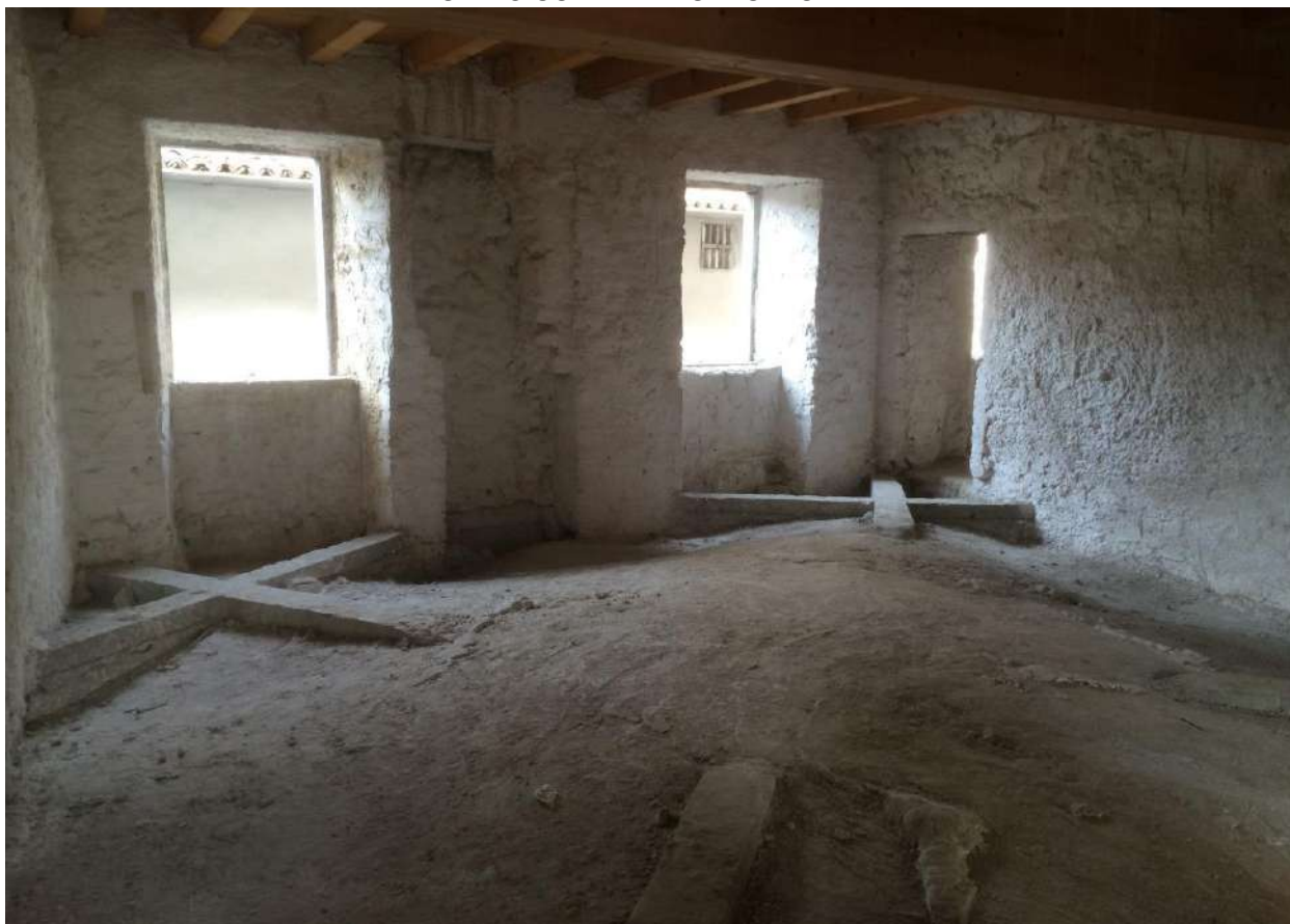
FOTO N. 15 – LOCALE PIANO PRIMO CON PAVIMENTO SOLAIO VOLTATO
