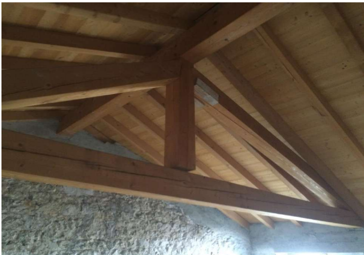
FOTO N. 26 – LOCALE PIANO SECONDO – PARTICOLARE DELLA CAPRIATA DI COPERTURA
