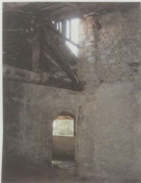
27. Vista orditura di copertura
