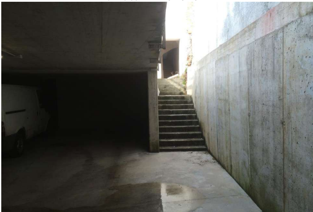
FOTO N. 33 – SCALA DI COLLEGAMENTO Piano Interrato con corte interna Piano Terra
