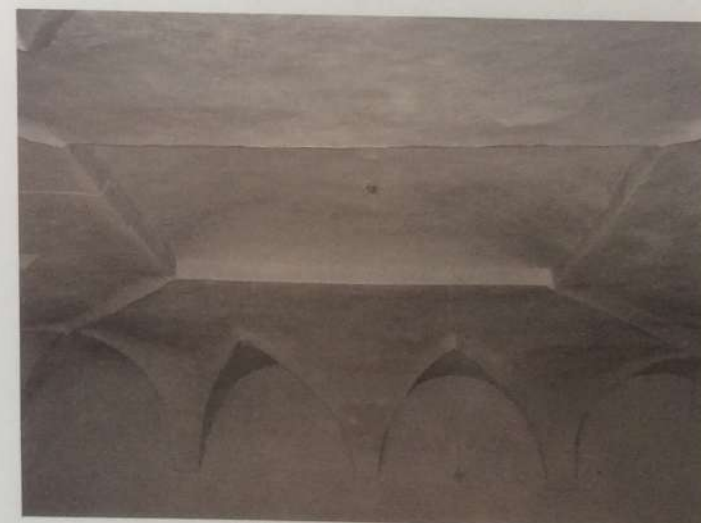
10. Particolare della copertura voltata
