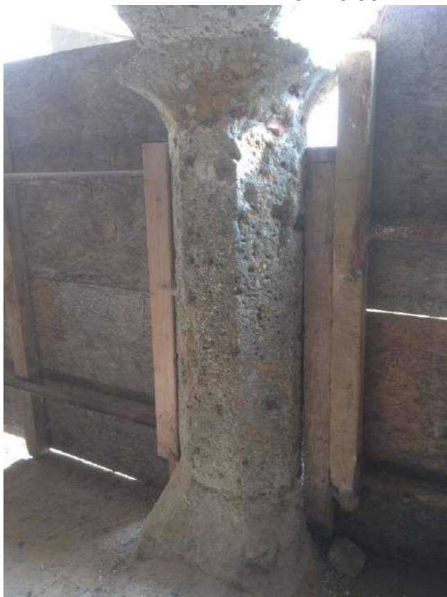
FOTO N. 31 – PARTICOLARE COLONNA IN PIETRA DEL PORTICATO PIANO TERRA
