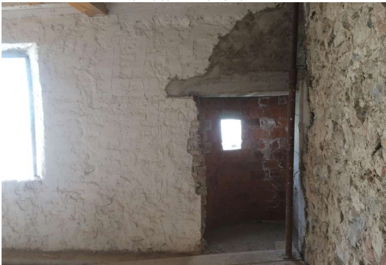
FOTO N. 21- LOCALE EX LATRINA ESTERNA
