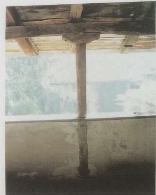
23.Particolare sostegno in legno
