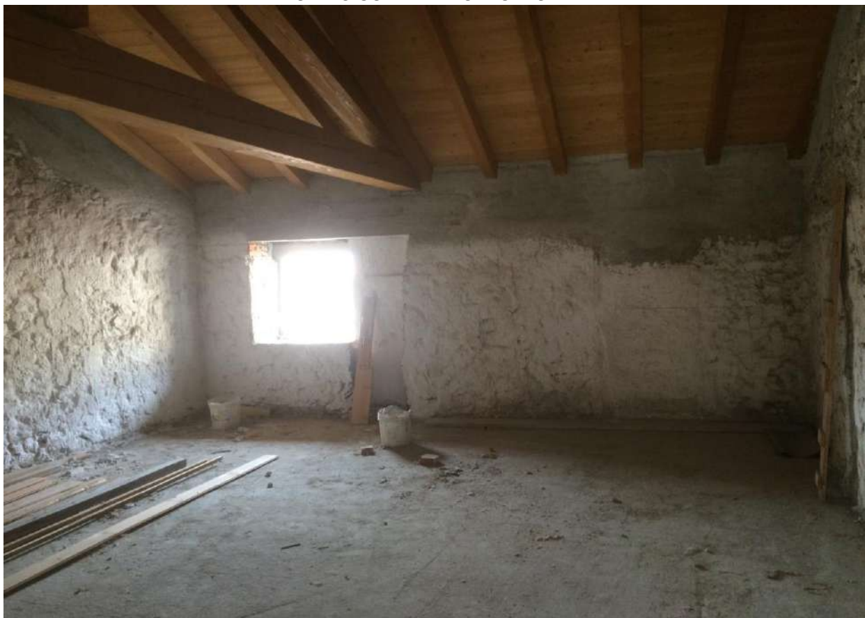
FOTO N. 25 – LOCALE PIANO SECONDO
