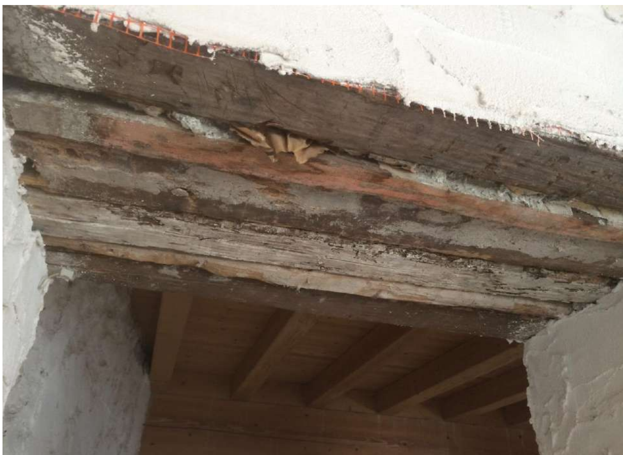
FOTO N. 30 – PARTICOLARE VOLTINI DELLE PORTE SUL PORTICO
