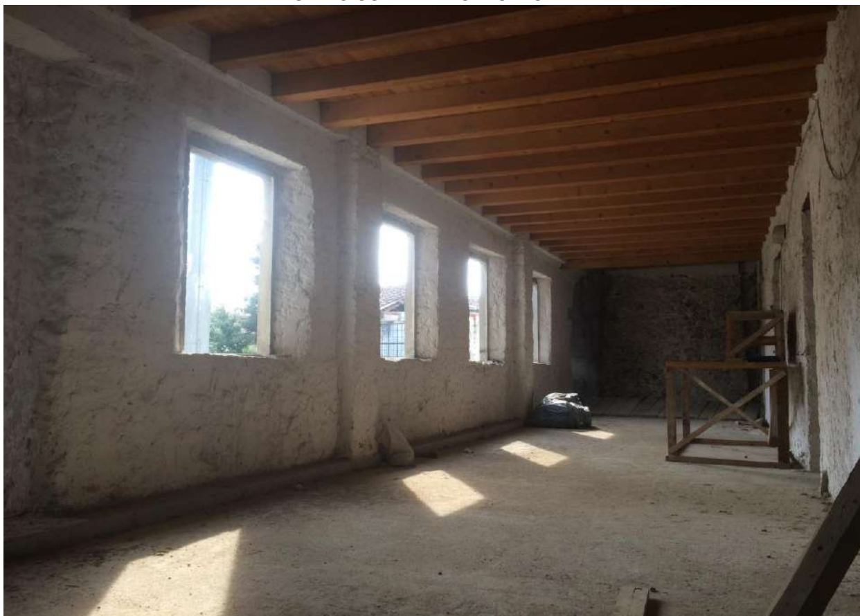
FOTO N. 13 – PORTICATO PIANO PRIMO vista parete lato esterno
