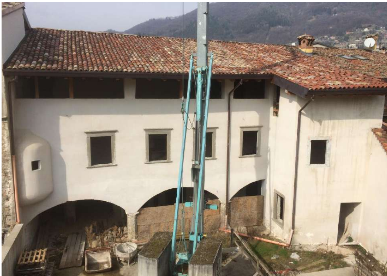
FOTO N. 5- ESTERNO EDIFICIO DALL'ALTO visto dalla corte interna
