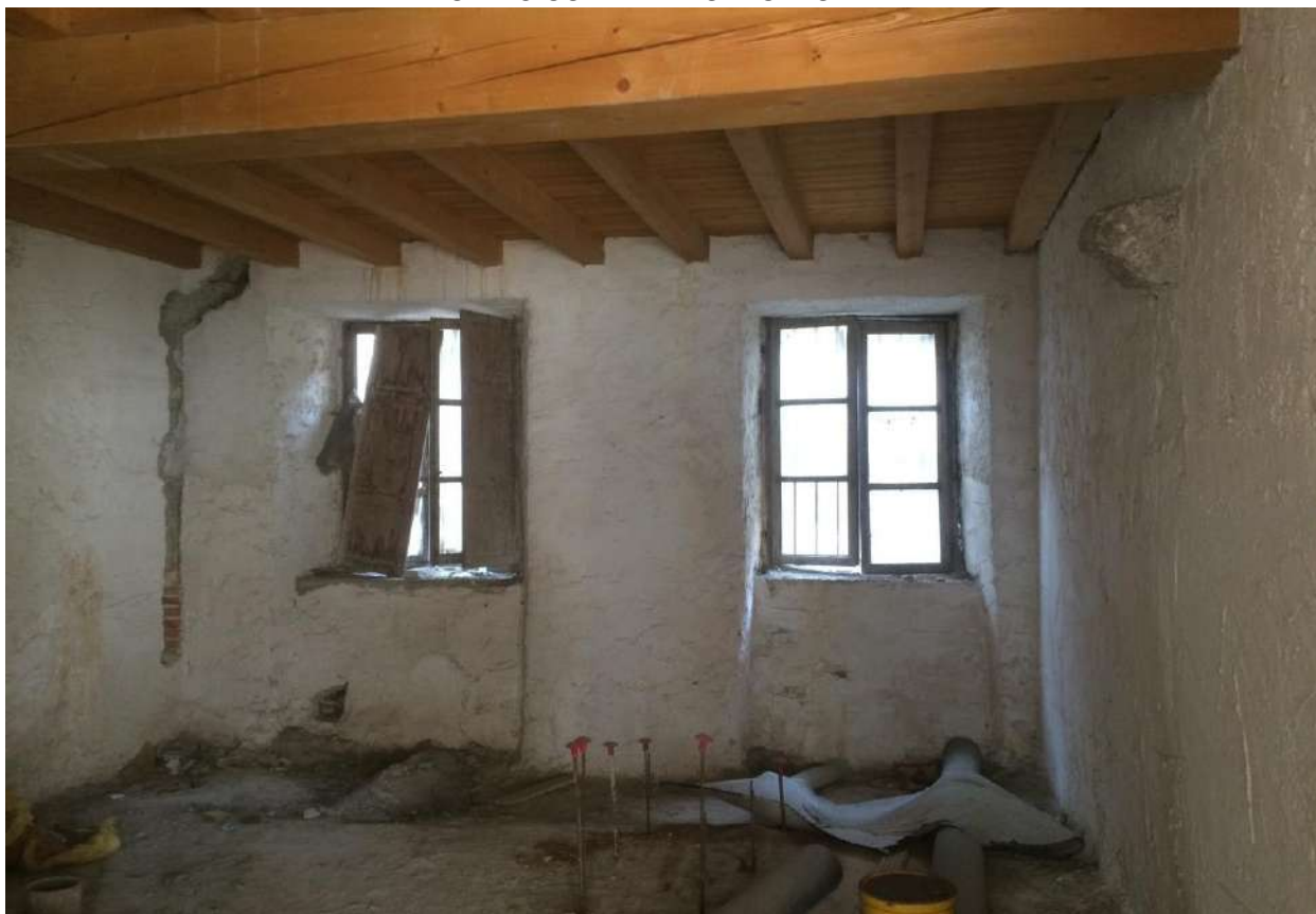
FOTO N. 7 – LOCALE PIANO TERRA lato est dell'androne d'ingresso
