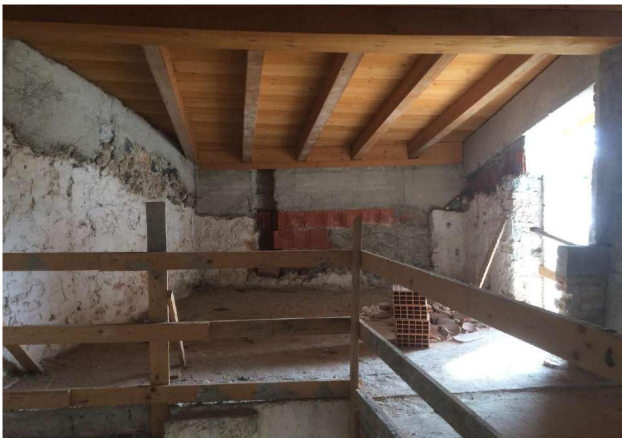
FOTO N. 24 – LOCALE PIANO SECONDO ADIACENTE ALLA SCALA
