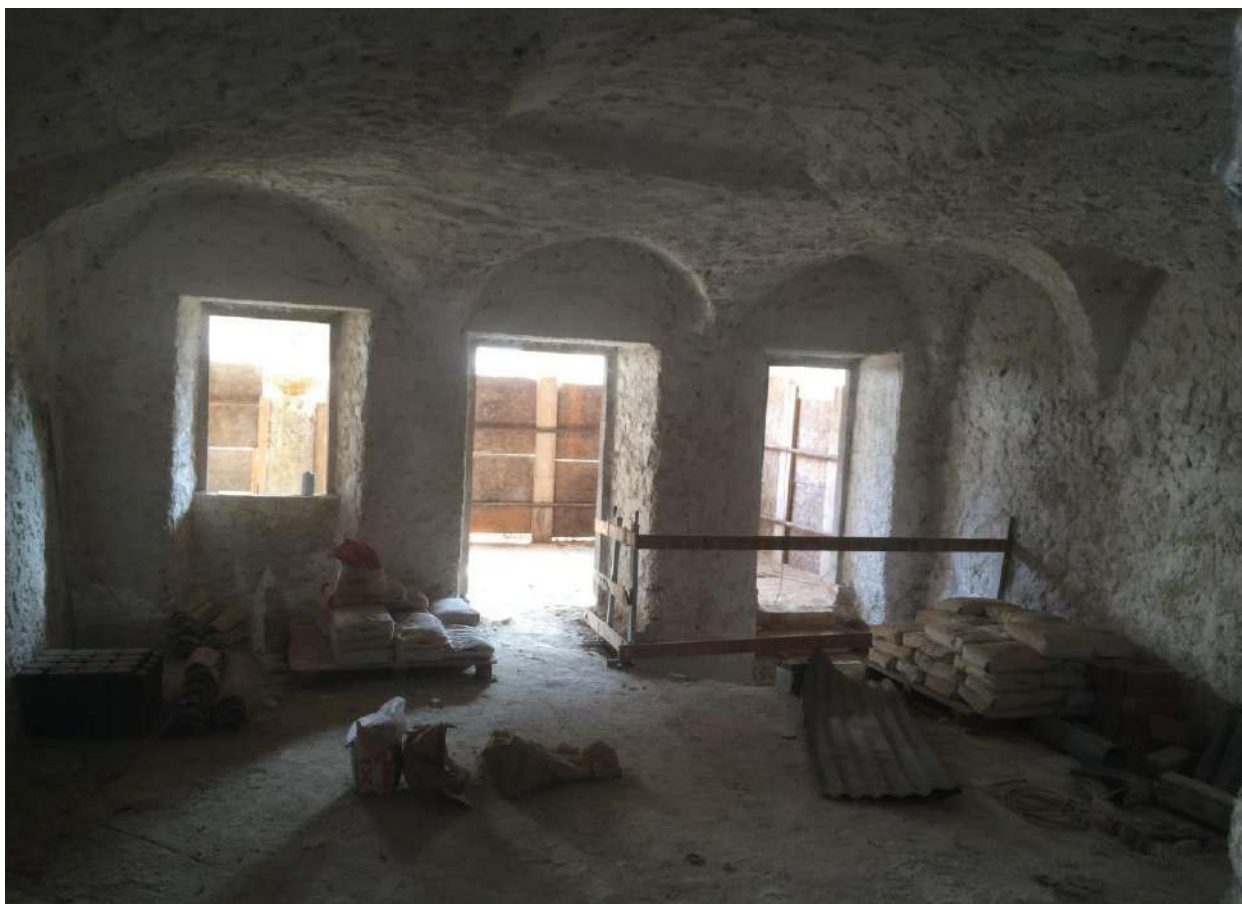
FOTO N. 8 – LOCALE PIANO TERRA SOLAIO VOLTATO lato ovest dell'androne d'ingresso
