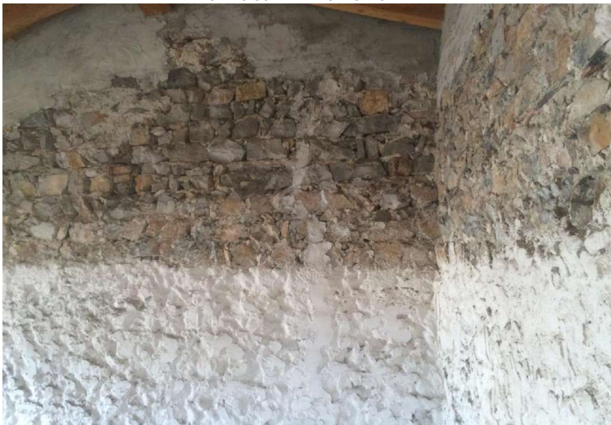
FOTO N. 29 – PARTICOLARE MURO IN SASSI
