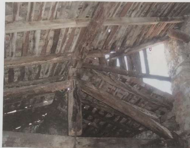
30. Particolare della capriata
