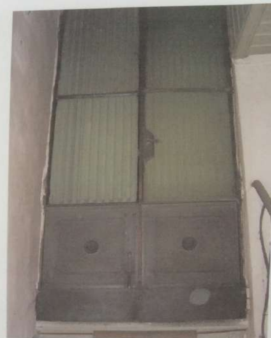
12. porta in ferro e vetro di accesso al piano primo
