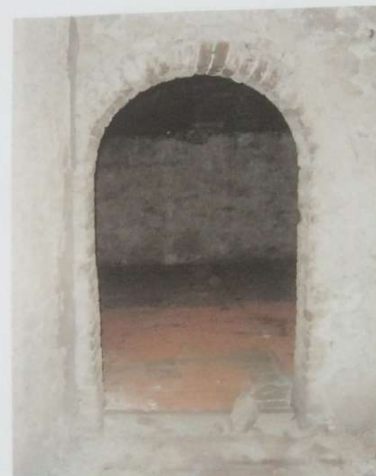
28. Particolare ingresso voltato in mattoni
