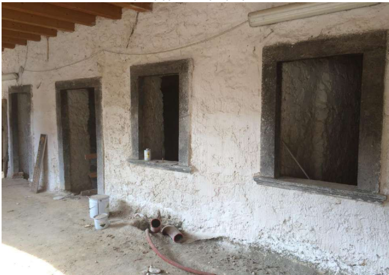
FOTO N. 11 – FRONTE INTERNO DEL PORTICATO
