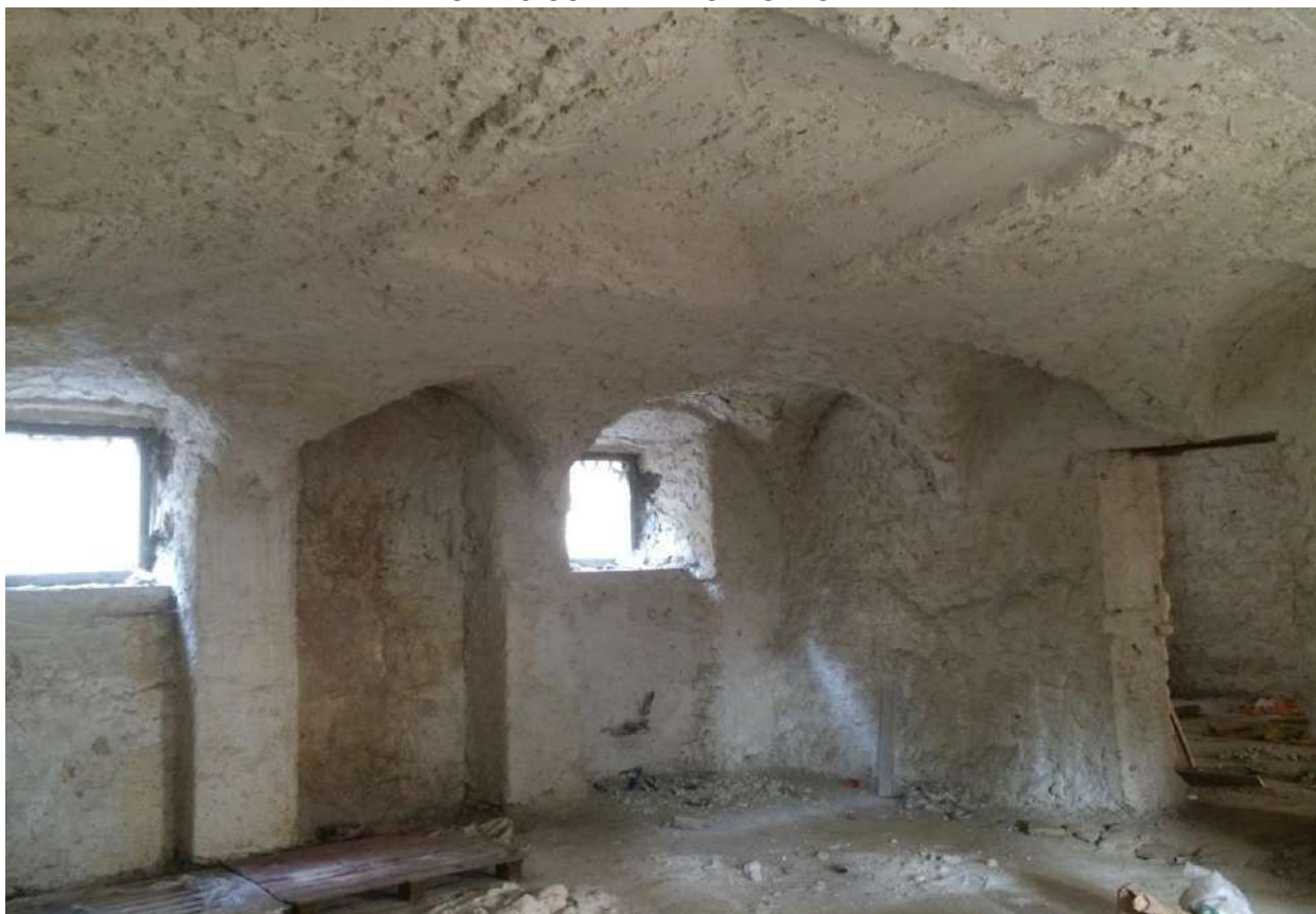
FOTO N. 9 – PARTICOLARE SOLAIO VOLTATO
