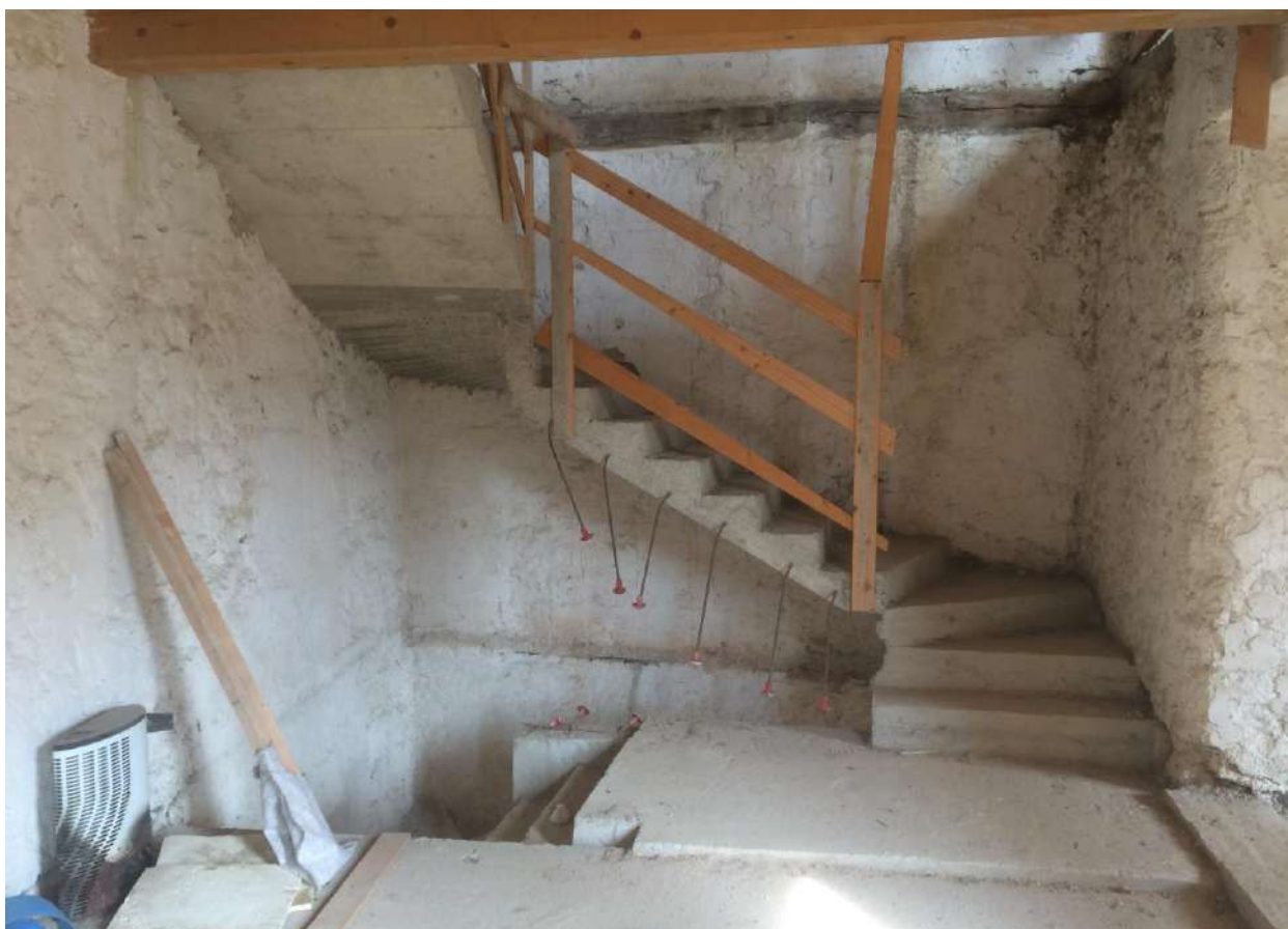
FOTO N. 22 - SCALA IN C.A. collegamento piano primo piano secondo
