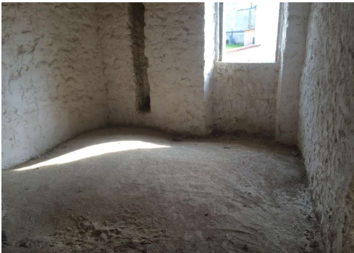
FOTO N. 18 – LOCALE PIANO PRIMO vista verso parete perimetrale esterna
