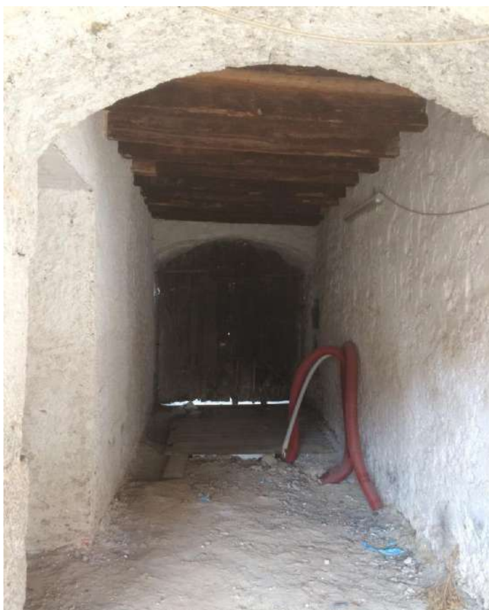
FOTO N. 6 – ANDRONE DI INGRESSO visto dalla corte interna
