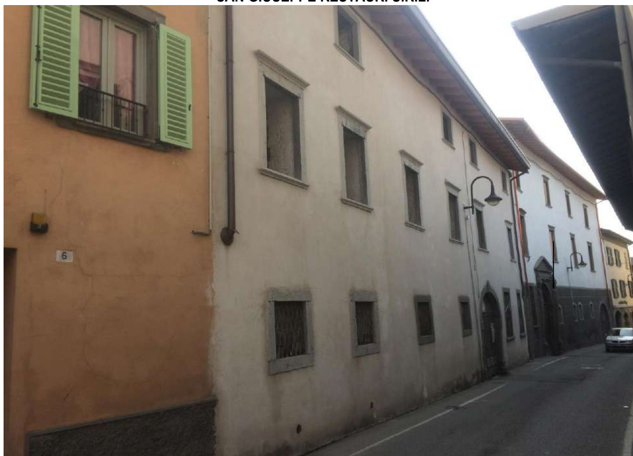
FOTO N. 1 – ESTERNO EDIFICIO da via Gian Battista Castello
