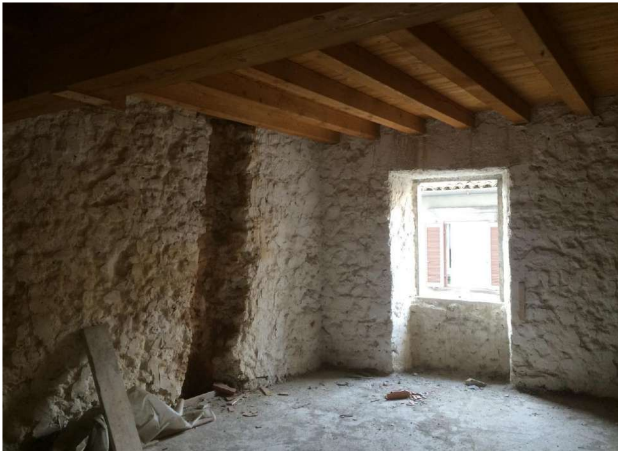
FOTO N. 19- LOCALE PIANO PRIMO particolare tracce pareti per predisposizione impianti
