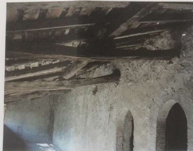
25.Particolare copertura loggiato
