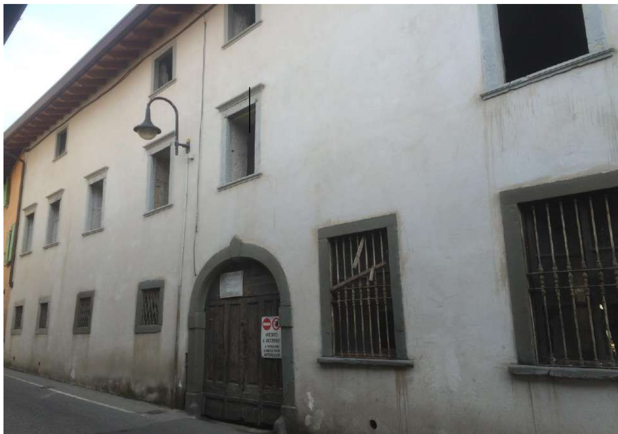
FOTO N. 2 – ESTERNO EDIFICIO da via Gian Battista Castello
