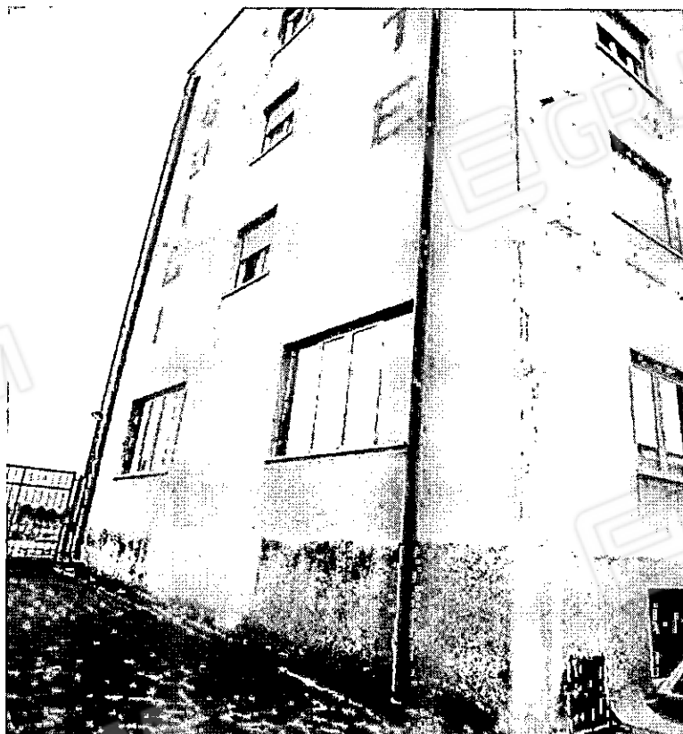
PROSPETTO SU CORTE INTERNA
