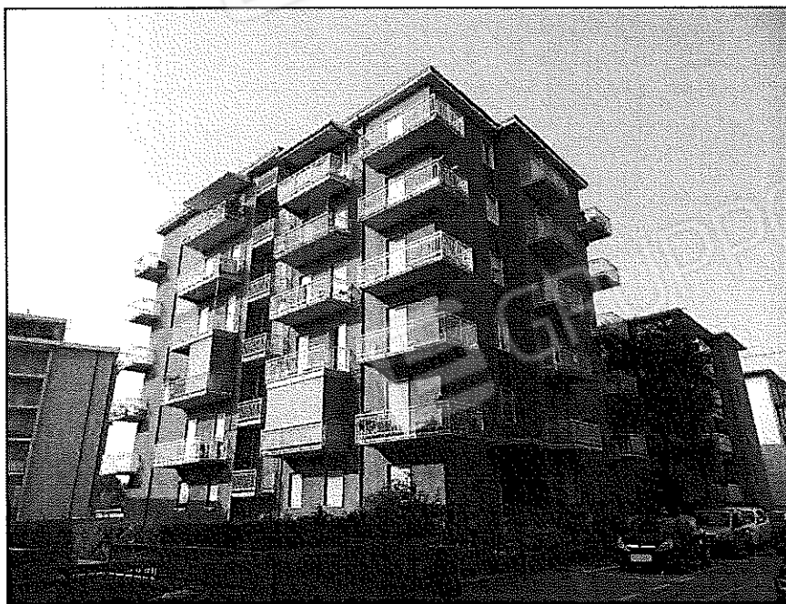
1. Vista del complesso immobiliare da via Simone Elia – prospetti est e nord
