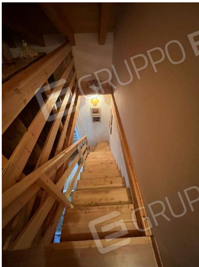
19. Scala di accesso al piano secondo sottotetto.
