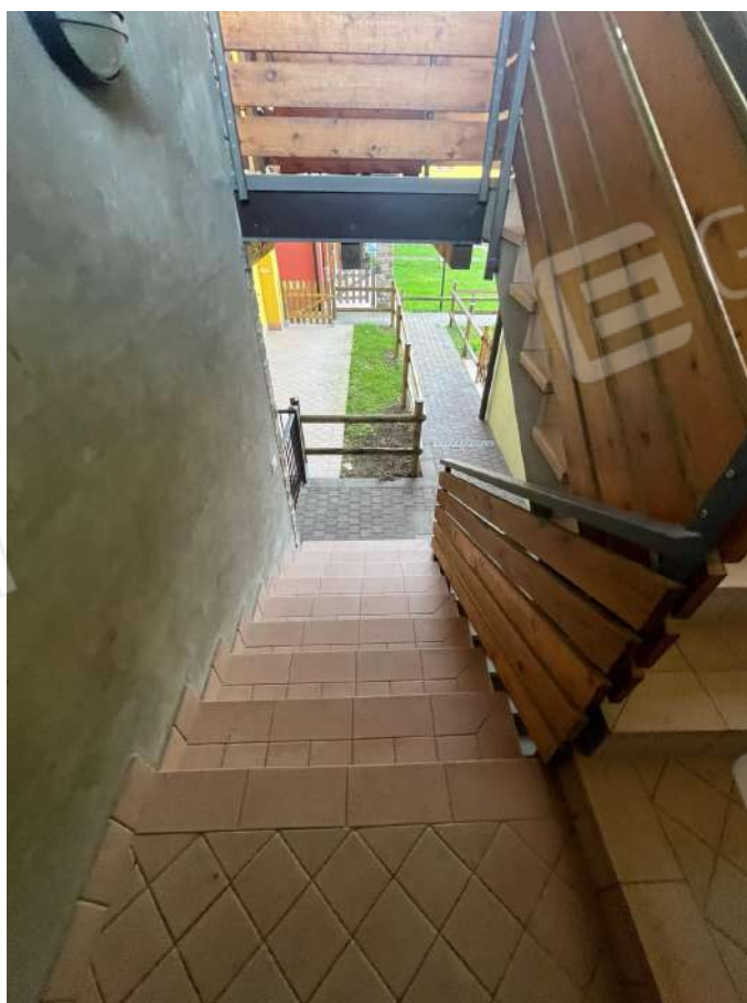
06. Scala comune di accesso al primo piano.
