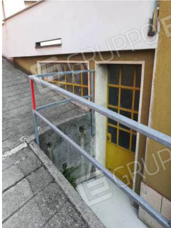
CANTINA CON ACCESSO ESTERNO
