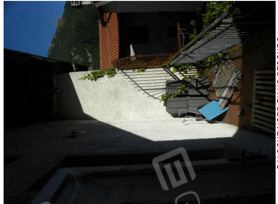
BALCONE NORD PIANO SECONDO
