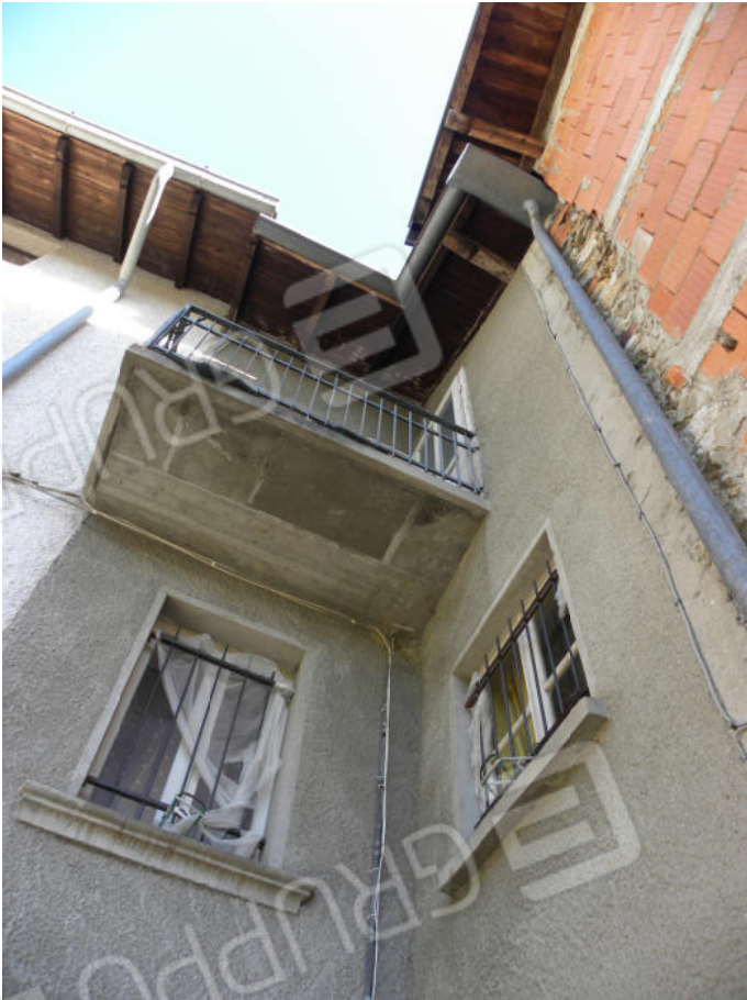
ESTERNO ANGOLO SUD EST
