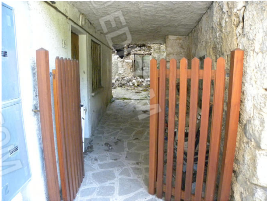
INGRESSO ANDRONE COPERTO
