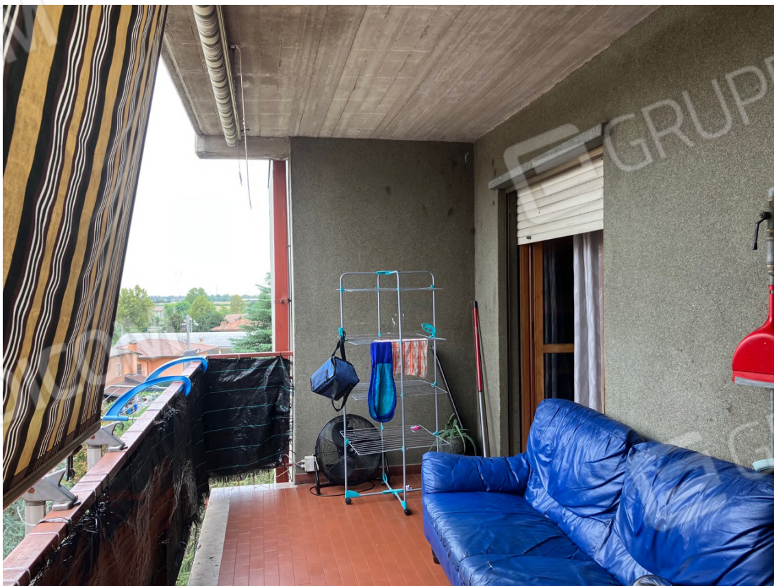
Foto n. 12 | Vista balcone con la porta-finestra del soggiorno.
