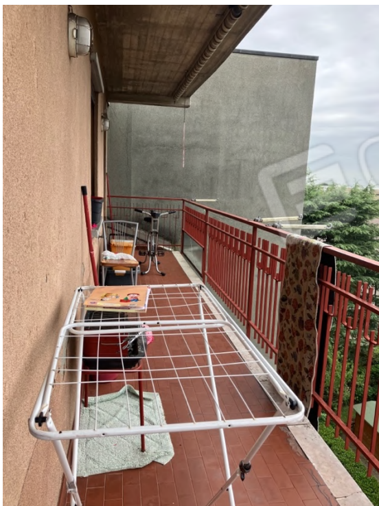
Foto n. 19 | Vista del balcone in corrispondenza della facciata posteriore.
