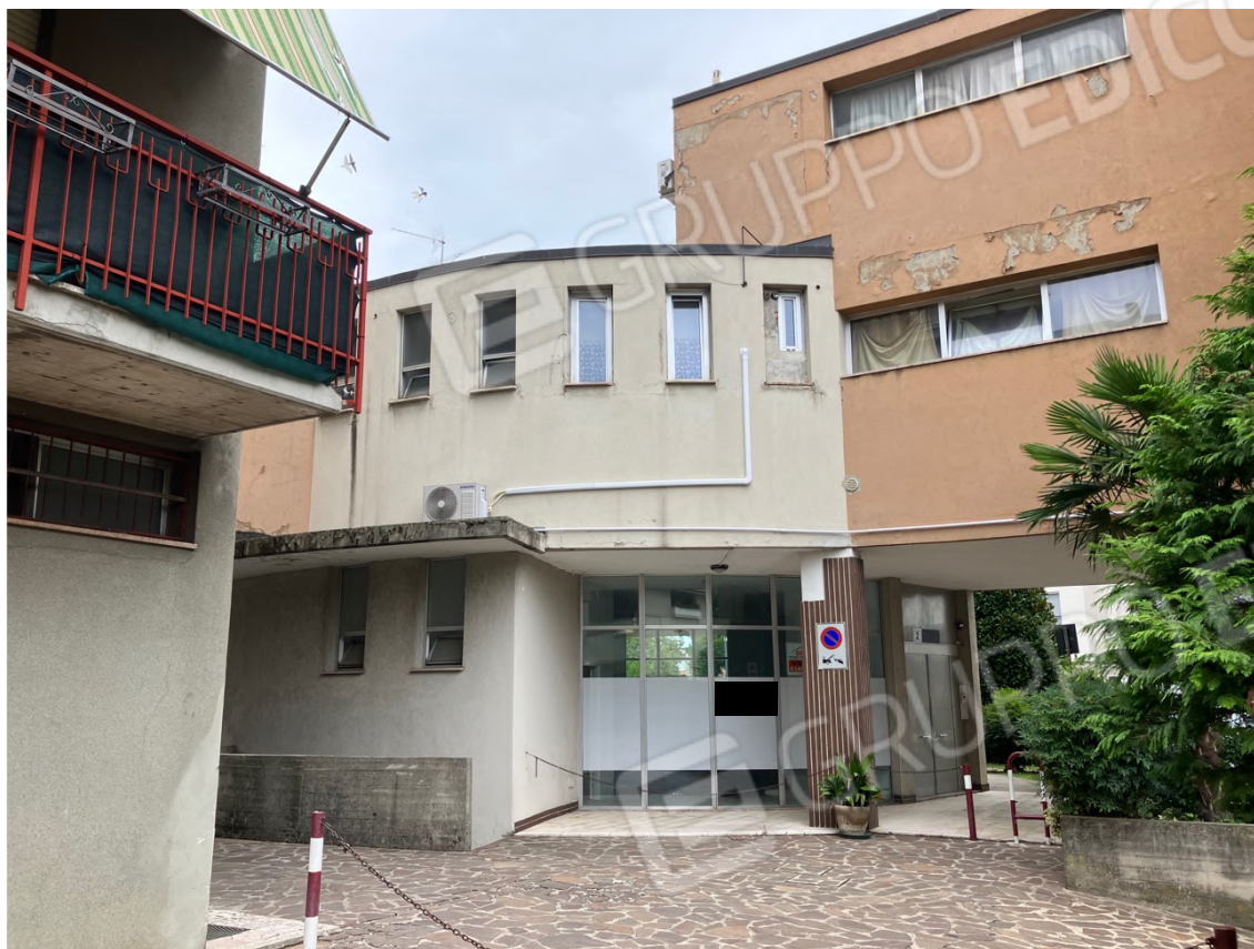
Foto n. 3 | Ingresso al complesso architettonico in corrispondenza di via Verdi.
