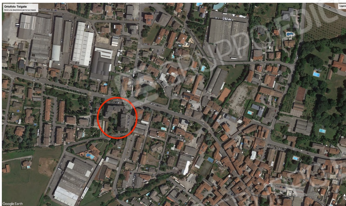
Foto n. 1 | Ortofoto del complesso residenziale.
