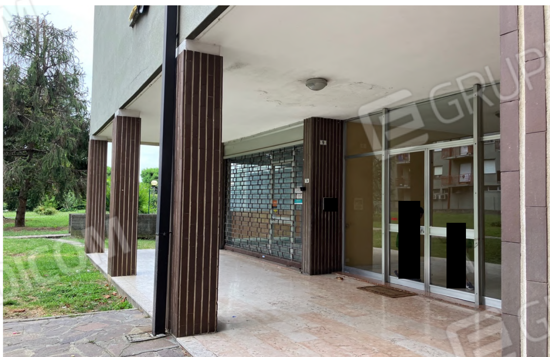
Foto n. 6 | Ingresso condominiale sotto il portico dell'edificio.
