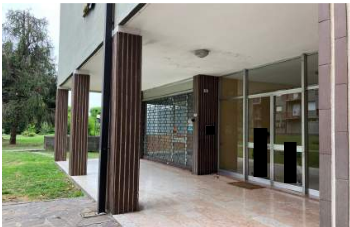
Foto n. 6 | Ingresso condominiale sotto il portico dell'edificio.
