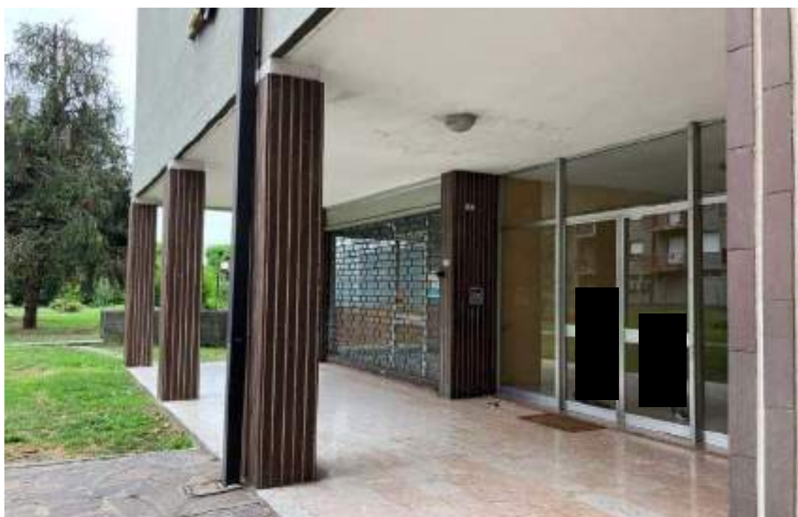
Foto n. 6 | Ingresso condominiale sotto il portico dell'edificio.
