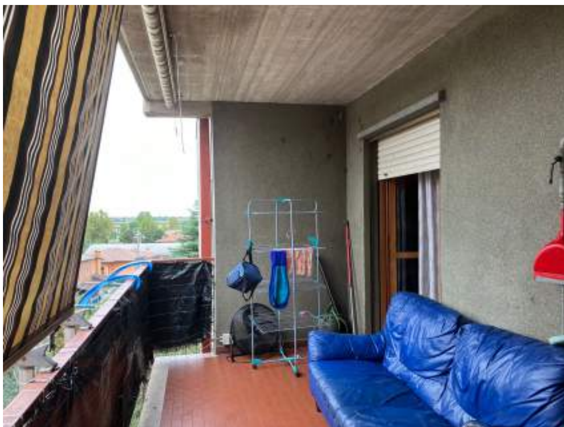
Foto n. 12 | Vista balcone con la porta-finestra del soggiorno.
