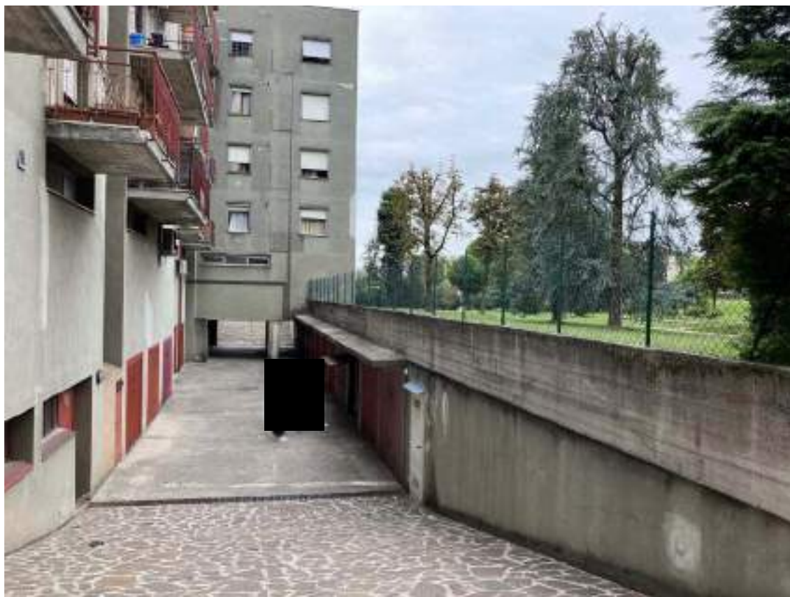
Foto n. 21 | Vista generale delle autorimesse interrato.
