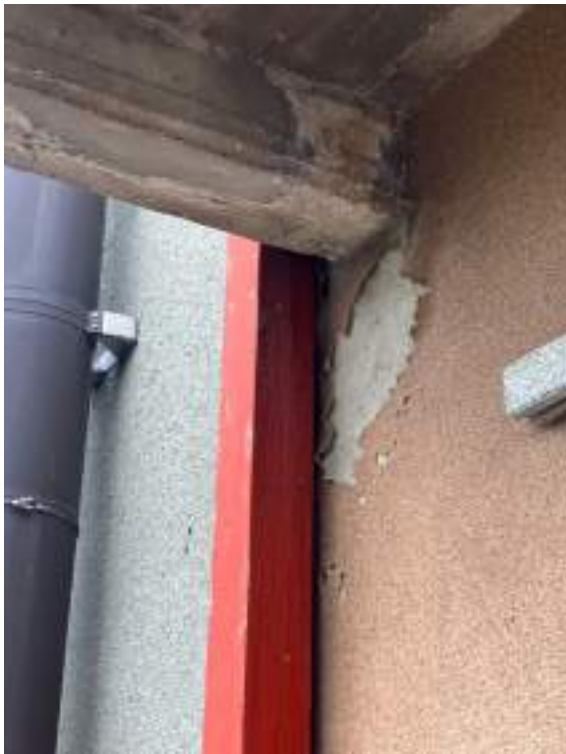
Foto n. 13 | Degrado del rivestimento di facciata e tracce di umidità sulla soletta superiore del balcone.
