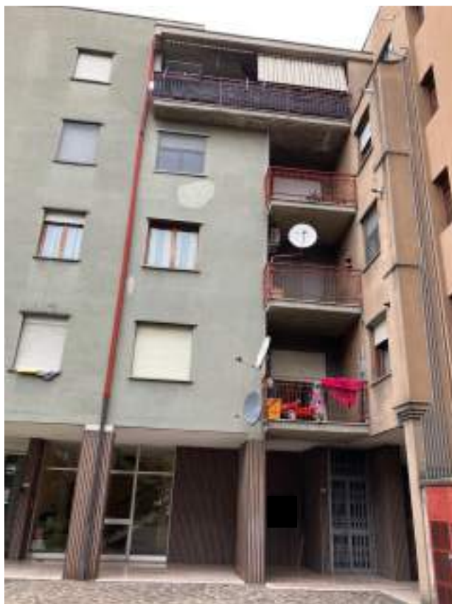
Foto n. 4 | Vista dell'edificio condominiale al civico n. 9 di via Donizetti. All'ultimo piano si vede il balcone dell'appartamento oggetto della presente procedura di esecuzione immobiliare.
