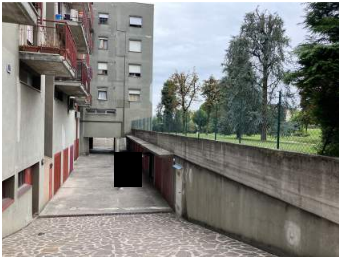
Foto n. 21 | Vista generale delle autorimesse interraste.
