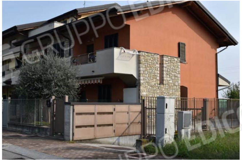
Foto n. 25 Vista dalla strada dell'appartamento mapp. 2892 sub 25
