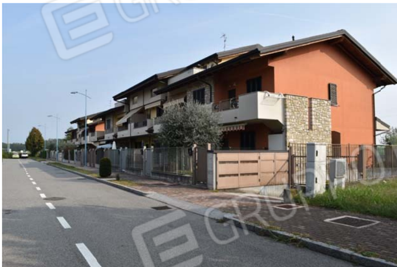
Foto n. 2 Vista del complesso residenziale dalla via Mantegna
