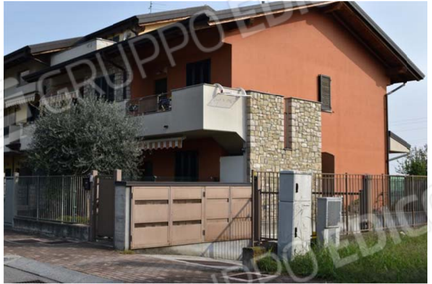
Foto n. 25 Vista dalla strada dell'appartamento mapp. 2892 sub 25
