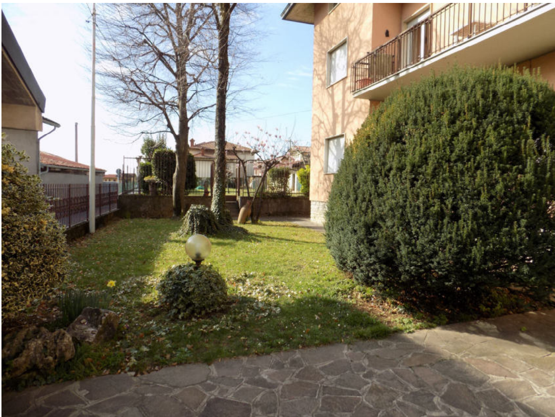
vista verso Sud-Est
