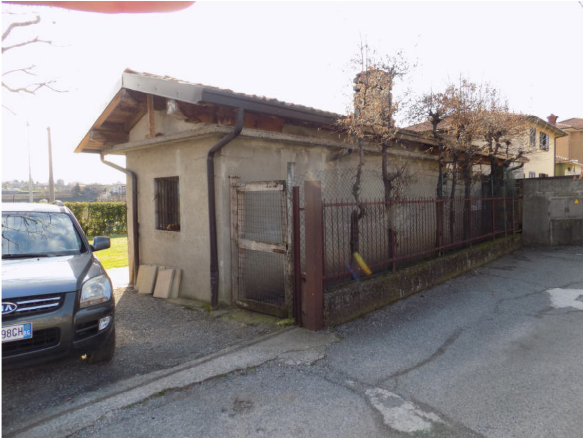
vista da Ovest – corpo accessorio mapp. 4623
