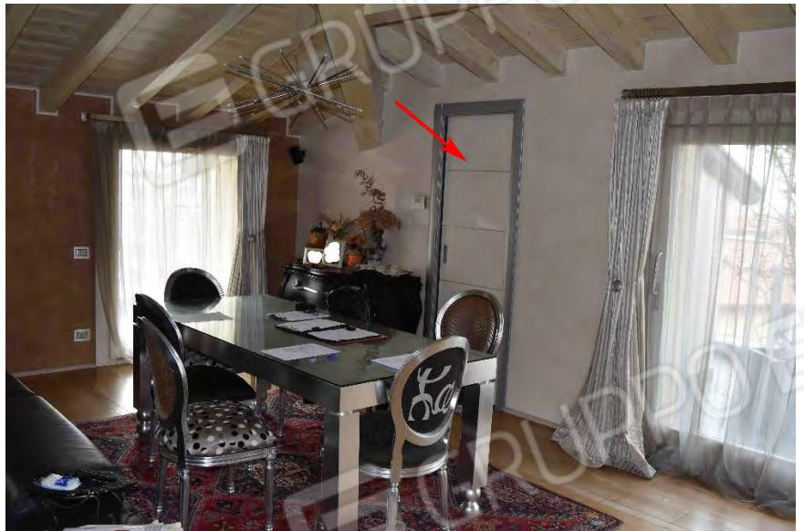
Soggiorno, accesso locale caldaia.
