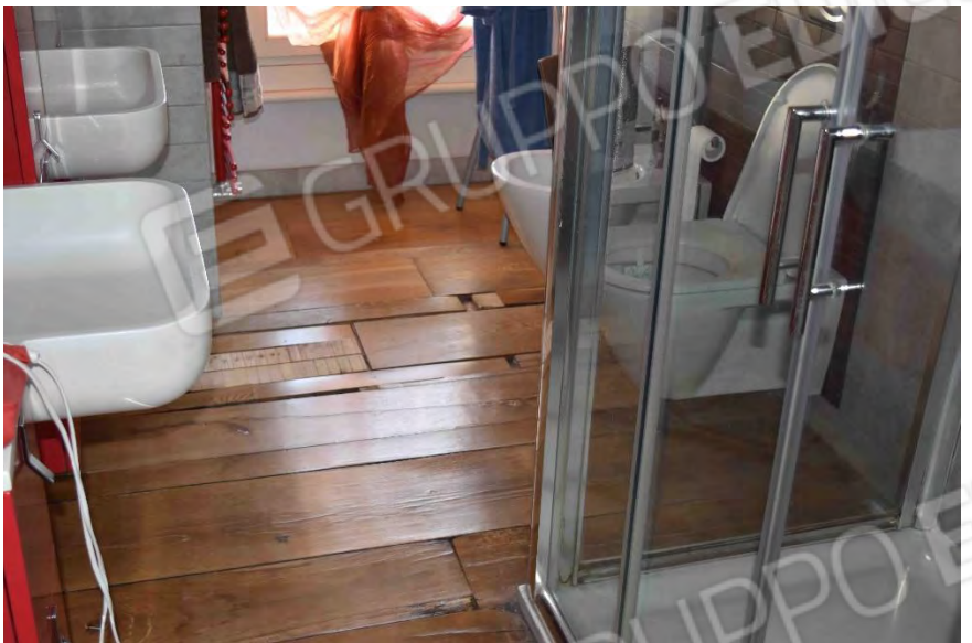
Bagno, z.g. danni pavimento legno.
