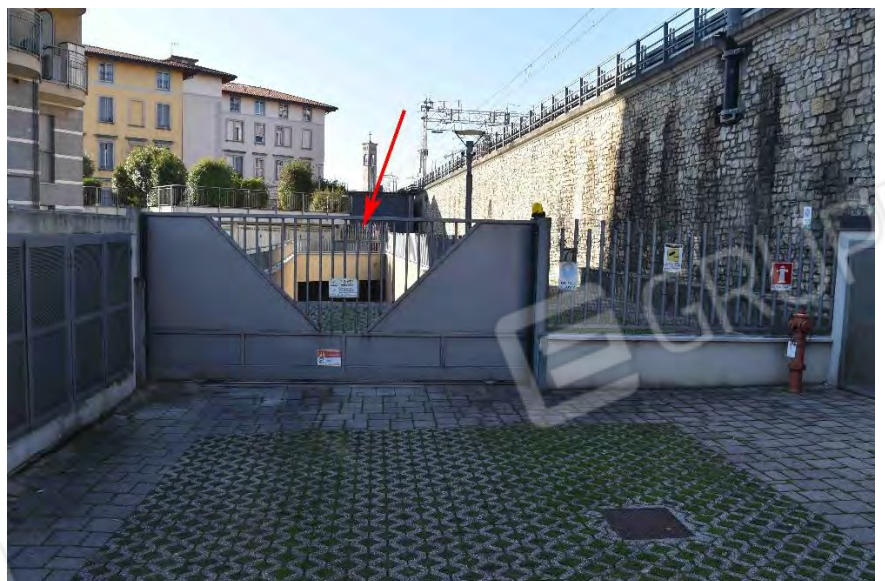
Cortile Nord, accesso carrale interrato.
