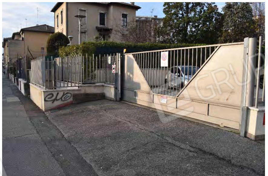
Accesso carrale a Sud.
