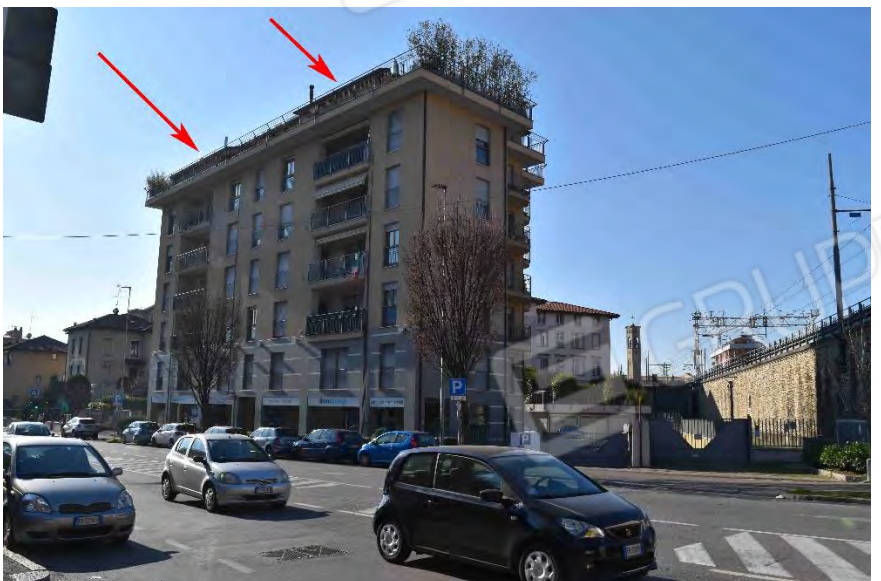
Prospetto Est, angolo Nord.
