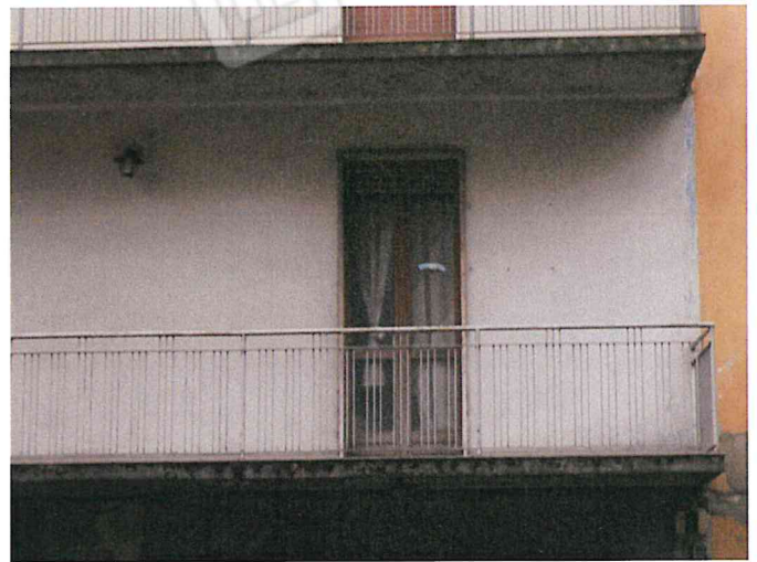
Foto 04 - Corpo A - prospetto Nord
