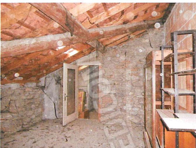
Foto 23 - Corpo C - interno - sottotetto porzione Ovest
