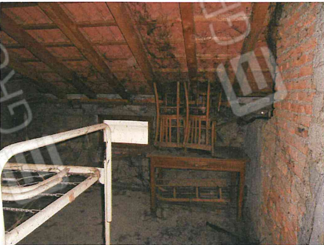
Foto 27 - Corpo C - interno - sottotetto porzione Est
