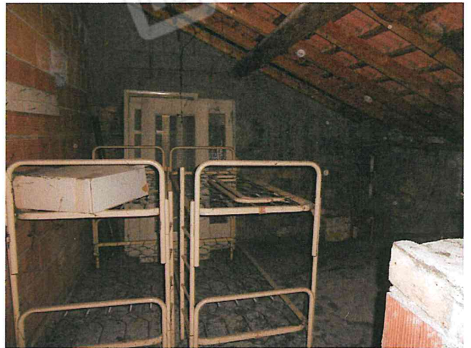
Foto 28 - Corpo C - interno - sottotetto porzione Est
