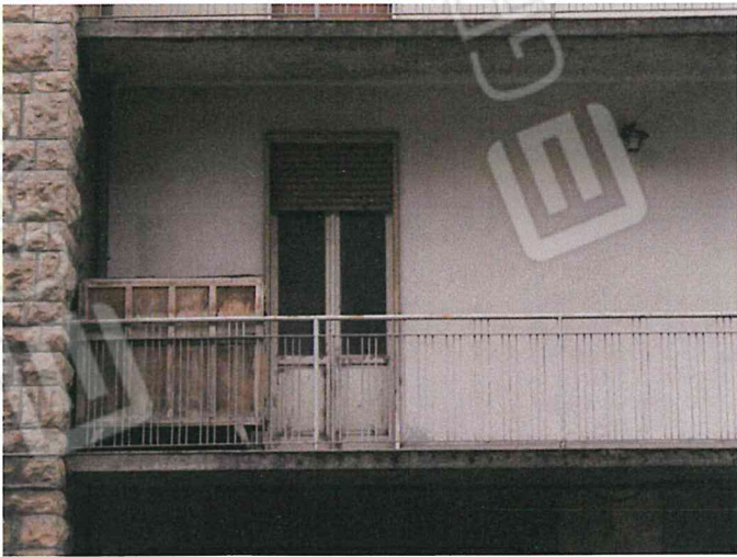
Foto 03 - Corpo A - prospetto Nord
