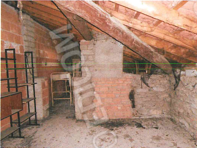
Foto 25 - Corpo C - interno - sottotetto porzione Ovest
