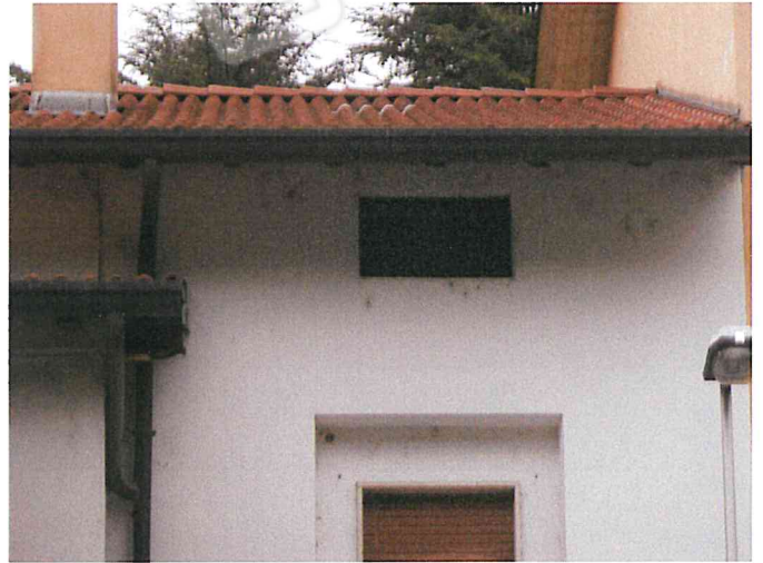
Foto 10 - Corpo C - Prospetto Sud
