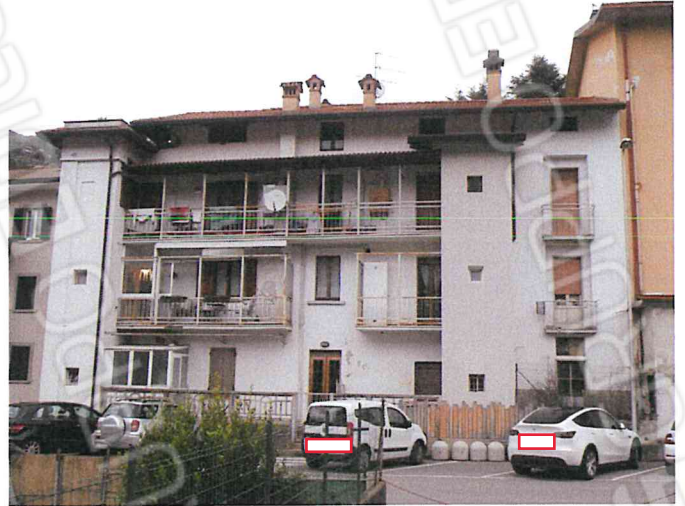
Foto 02 - Vista edificio prospetto Sud
