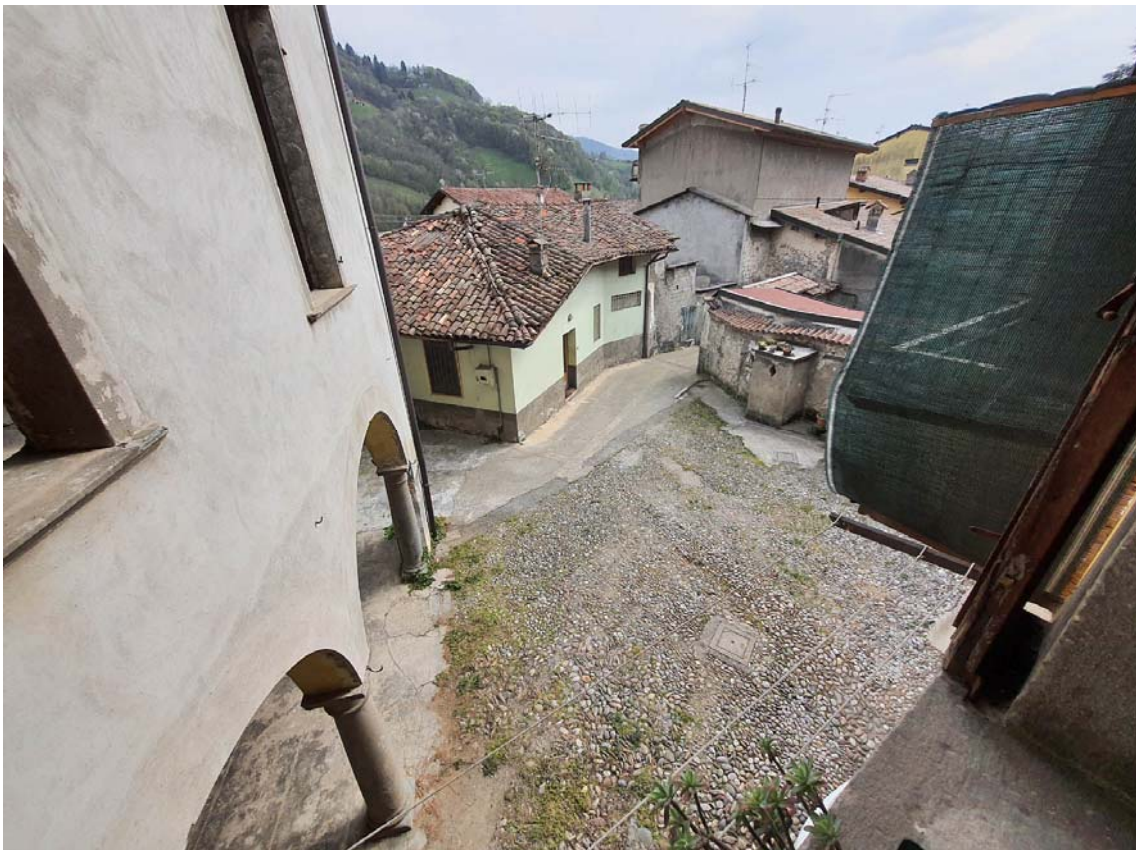
RILIEVO PARTI COMUNI ESTERNE – Foto 13-15 Dettagli facciate e portico ad archi e vele, impostato su colonne. Identificazione della porzione di immobile soggetto a procedura, ai piani primo e secondo. Ripresa della corte comune dall'alto.
