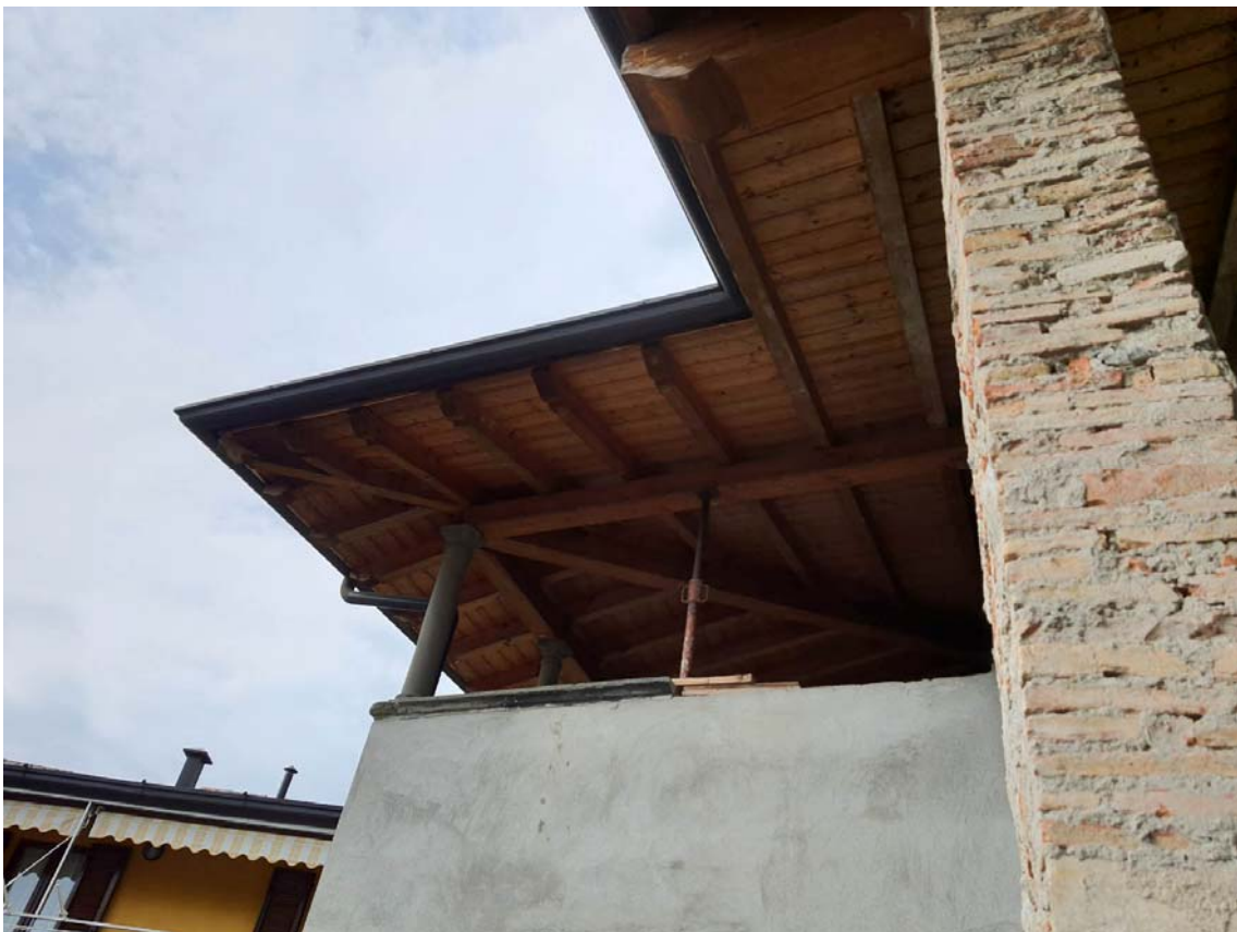
RILIEVO SUBALTERNO 4 – Unità Immobiliare 2 di progetto – Foto 70-72. Viste sulle facciate esterne e della copertura in legno rinnovata.
