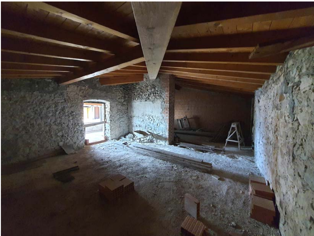
RILIEVO SUBALTERNO 5 – Singola Unità Immobiliare di progetto – Foto 82 e 83. Riprese della zona che è destinata ai locali camera letto 1 e bagno dal progetto preliminare*. (Nota *: si vedano le planimetrie di rilievo peritale e il progetto preliminare proposto in sede di Procedura Fallimentare n. 171/2002).
