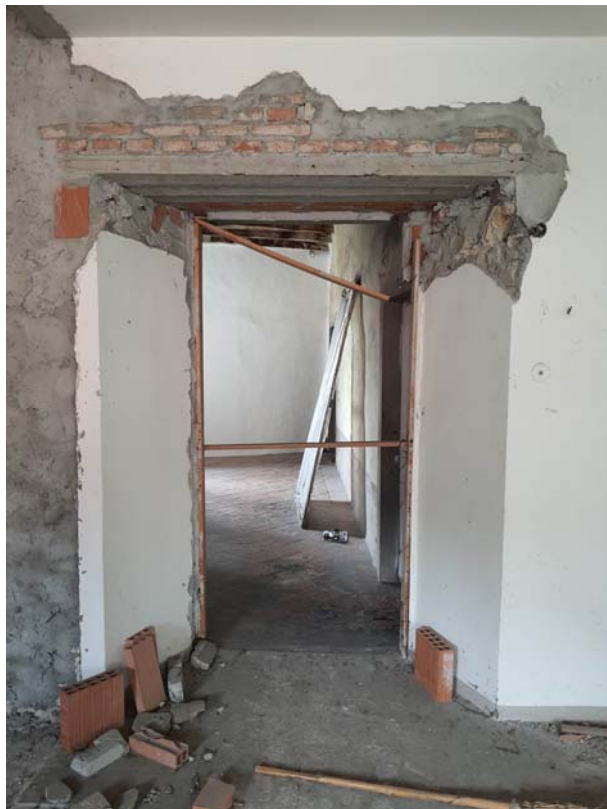
RILIEVO SUBALTERNO 4 – Unità Immobiliare 1 di progetto – Foto 37 e 38. Porta di accesso all'Unità Immobiliare 1.
