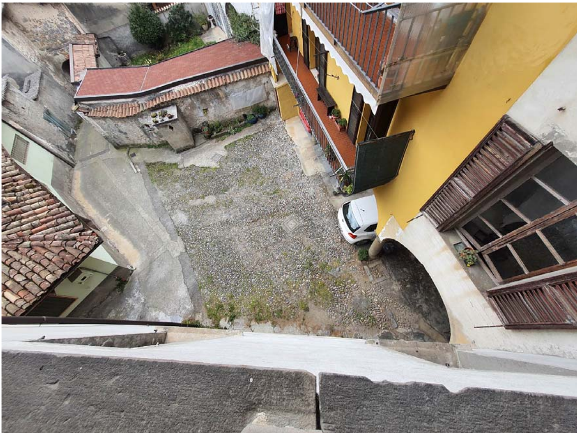
RILIEVO SUBALTERNO 5 – Singola Unità Immobiliare di progetto – Foto 100-102. Le facciate esterne e la corte viste dal Loggiato.
