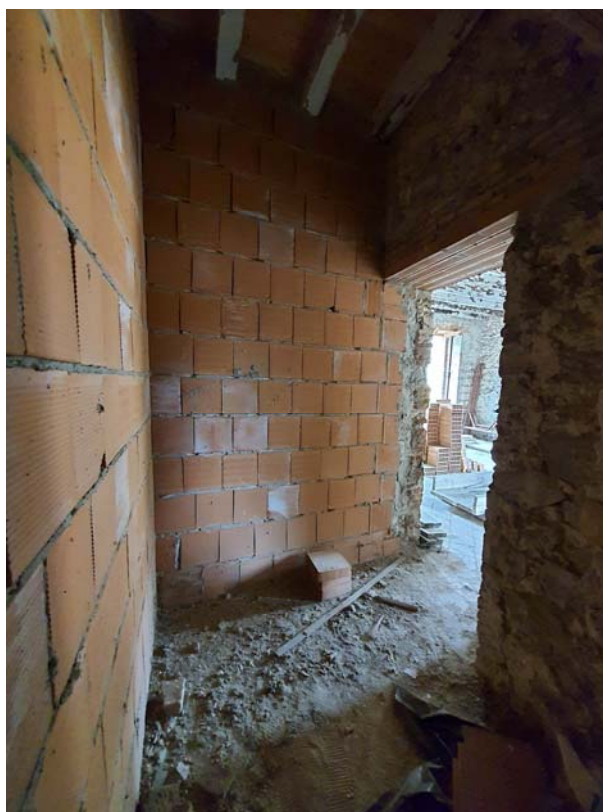
RILIEVO SUBALTERNO 4 – Unità Immobiliare 1 di progetto – Foto 35 e 36. Area appartenente al previsto locale bagno ma non completata dei relativi tavolati di separazione.
