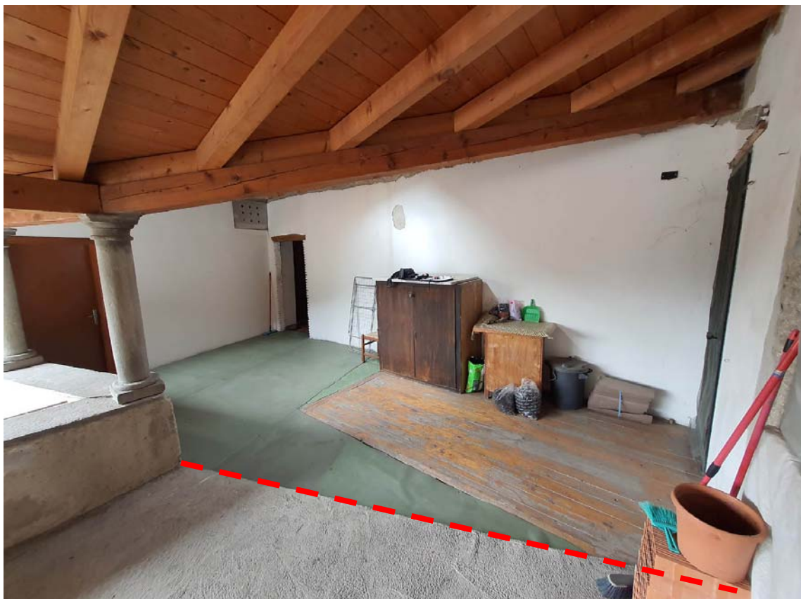
RILIEVO SUBALTERNO 5 – Singola Unità Immobiliare di progetto – Foto 77-77. Viste della rampa scale di collegamento con il secondo piano e dello spazio comune della Loggia.
