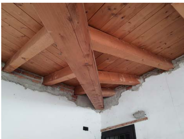
RILIEVO SUBALTERNO 5 – Singola Unità Immobiliare di progetto – Foto 85-90. Dettagli della copertura in legno rinnovata e di lucernario con serramento a vasistas.
