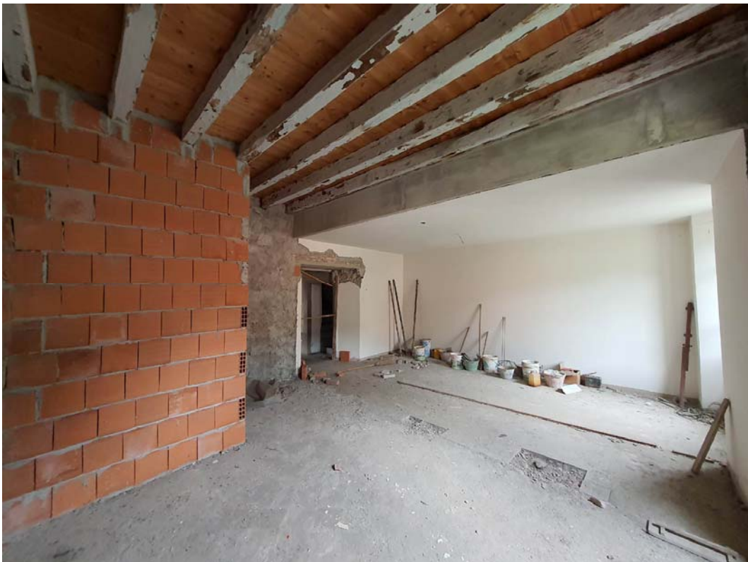
RILIEVO SUBALTERNO 4 – Unità Immobiliare 1 di progetto – Foto 39 e 40. Vista del vano unico dell'Unità Immobiliare 1 che da progetto* dovrebbe ospitare I locali soggiorno/pranzo/cottura, camera letto e disimpegno di accesso al locale bagno. (Nota *: si vedano le planimetrie di rilievo peritale e il progetto preliminare proposto in sede di Procedura Fallimentare n. 171/2002).
