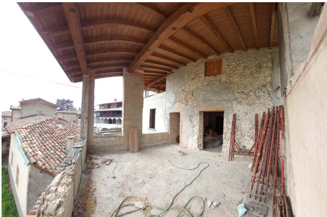
RILIEVO SUBALTERNO 4 – Unità Immobiliare 2 di progetto – Foto 55-59. Dettagli dei solai in legno tra primo e secondo piano e della copertura in legno rinnovata.
