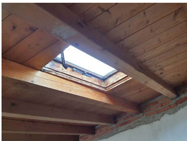
RILIEVO SUBALTERNO 5 – Singola Unità Immobiliare di progetto – Foto 85-90. Dettagli della copertura in legno rinnovata e di lucernario con serramento a vasistas.
