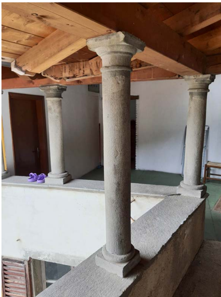
RILIEVO SUBALTERNO 5 – Singola Unità Immobiliare di progetto – Foto 97-99. Dettagli tessitura muraria originaria e colonna del Loggiato.
