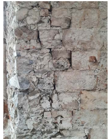
RILIEVO SUBALTERNO 4 – Unità Immobiliare 2 di progetto – Foto 64-69. Abaco pavimentazioni al rustico, in cotto e dettaglio tessitura muraria originaria.
