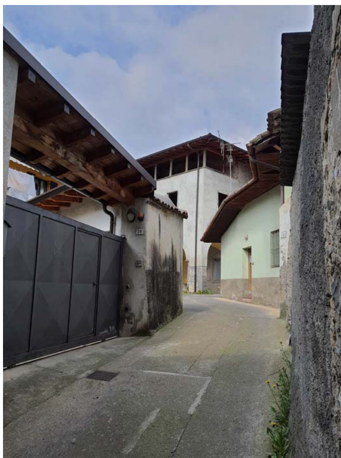
RILIEVO ESTERNO – Foto 9 e 10.
