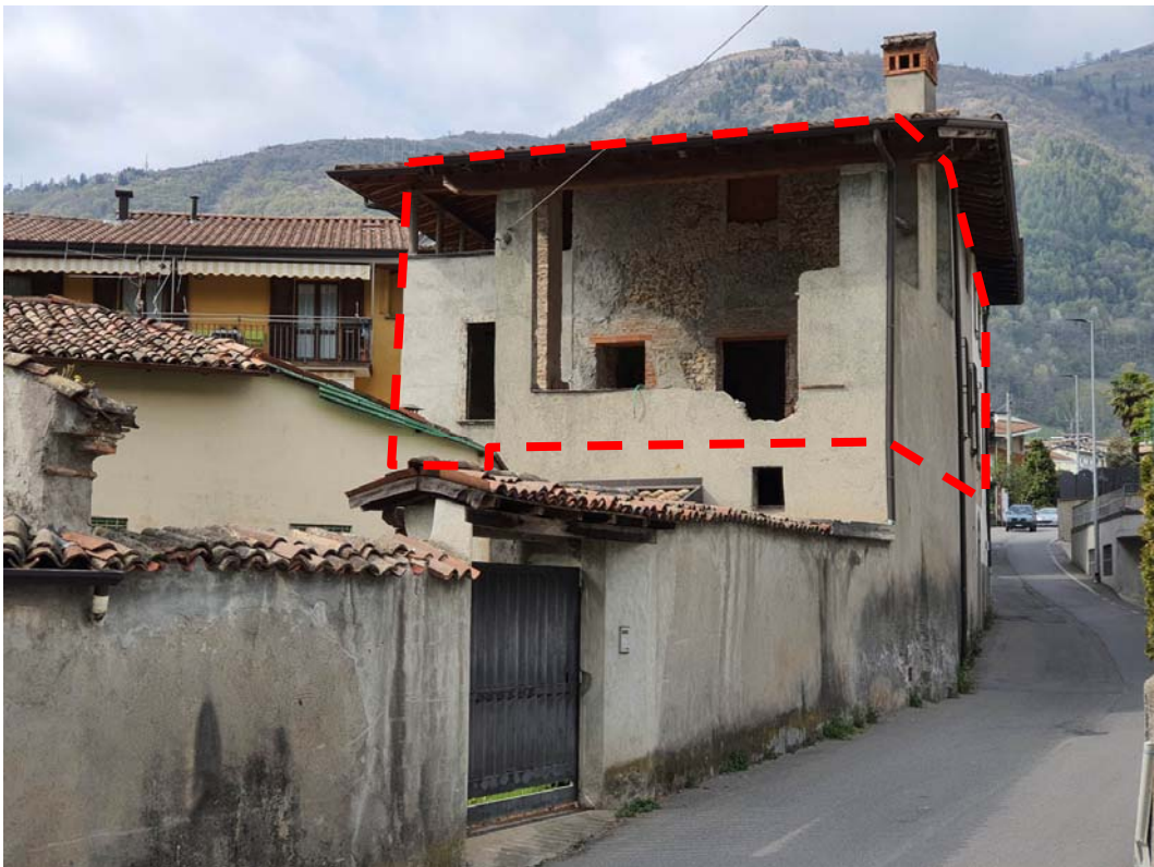
RILIEVO ESTERNO – Foto 1 e 2 - Il fabbricato visto da Sud, dalla via A. DIAZ. Identificazione della porzione di immobile soggetto a procedura, ai piani primo e secondo.
