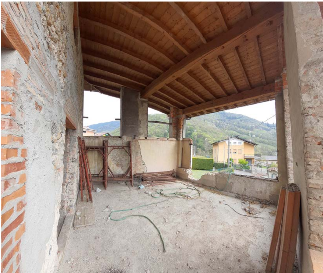
RILIEVO SUBALTERNO 4 – Unità Immobiliare 2 di progetto – Foto 53 e 54.
