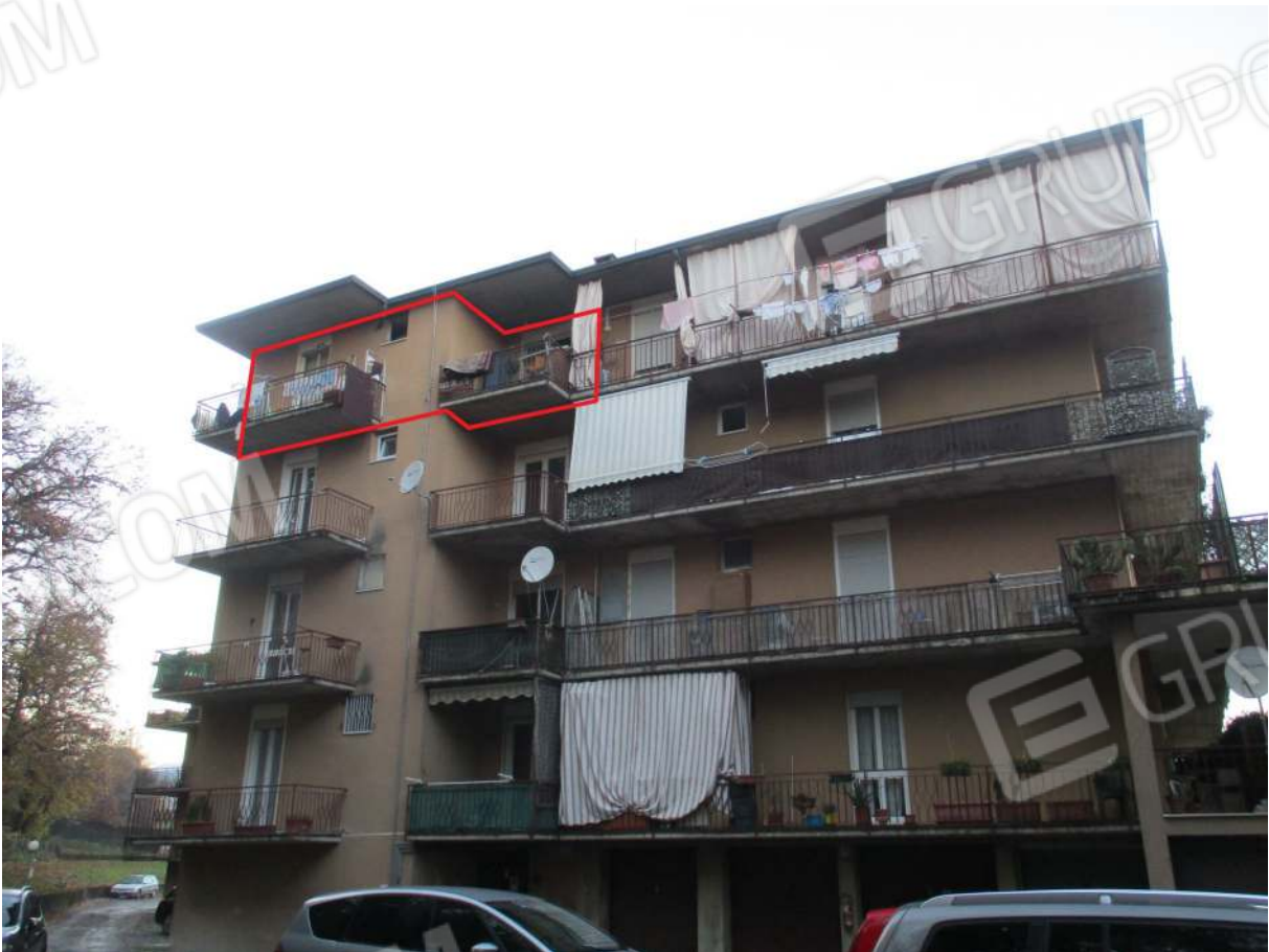
Fig. 4 – Vista d'insieme della palazzina B (lato sud) con l'alloggio al P. 3° riquadrato in rosso
