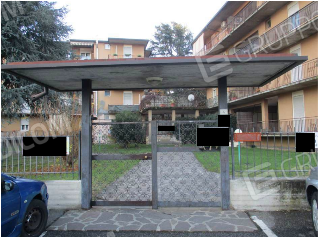
Fig. 6 – Vista dell'accesso pedonale al complesso posto su Via Fosio
