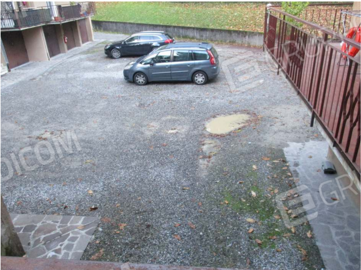
Fig. 12 – Vista del cortile comune posto sul retro del complesso (lato ovest)
