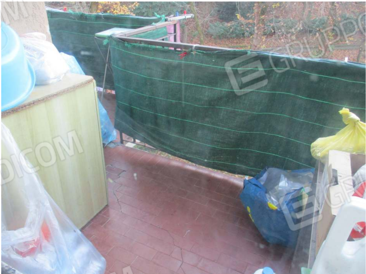
Fig. 23 – Vista del balcone con accesso dalla cucina
