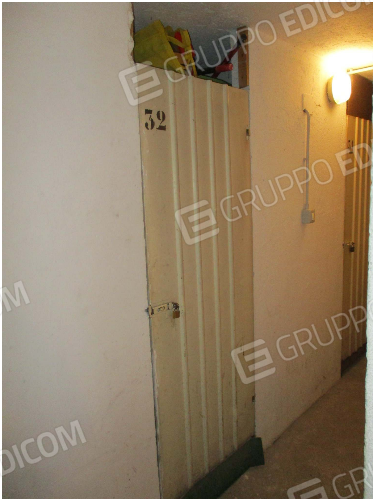
Fig. 39 – Vista della porta della cantina pertinenziale all'alloggio oggetto di stima
