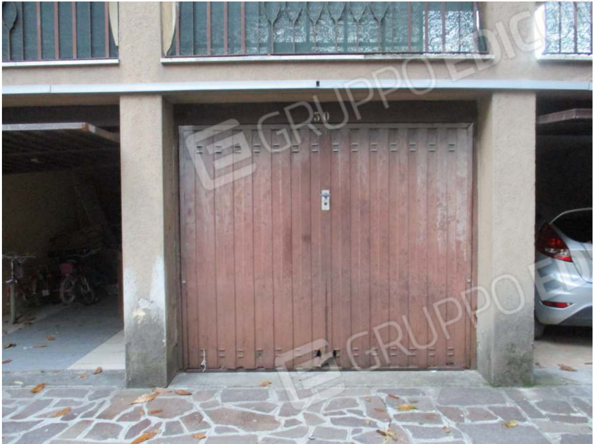
Fig. 41 – Vista della basculante del box pertinenziale all'alloggio oggetto di stima
