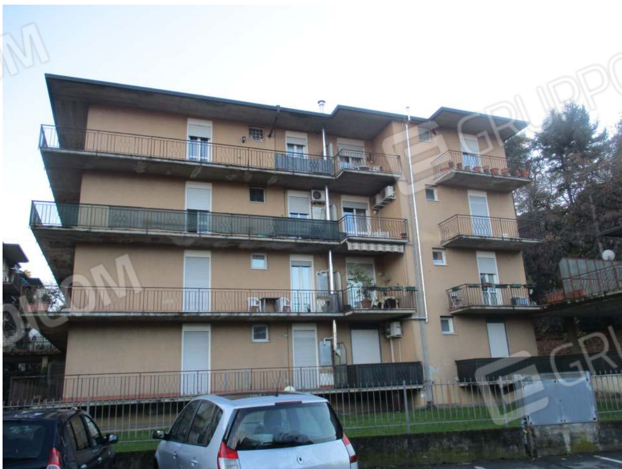
Fig. 2 – Vista d'insieme della palazzina B da Via Fosio (prospetto nord)
