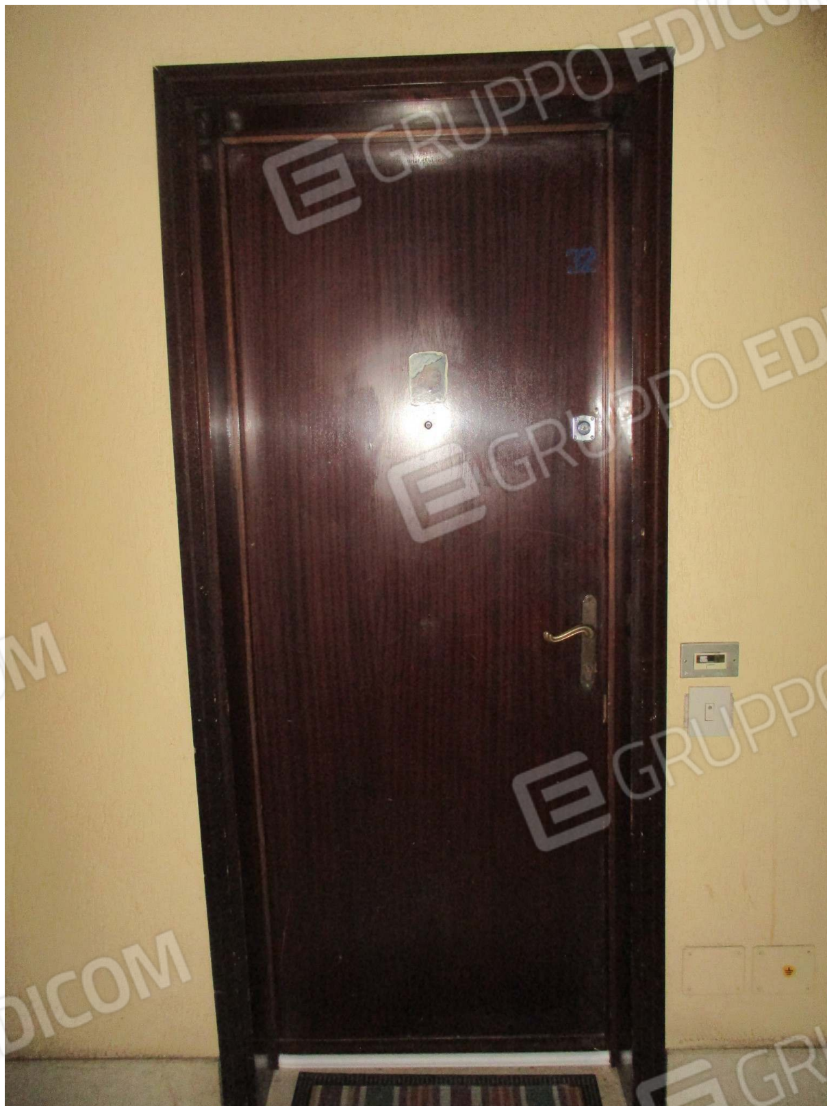
Fig. 18 – Vista del portoncino d'ingresso dell'appartamento al P.3° oggetto di stima
