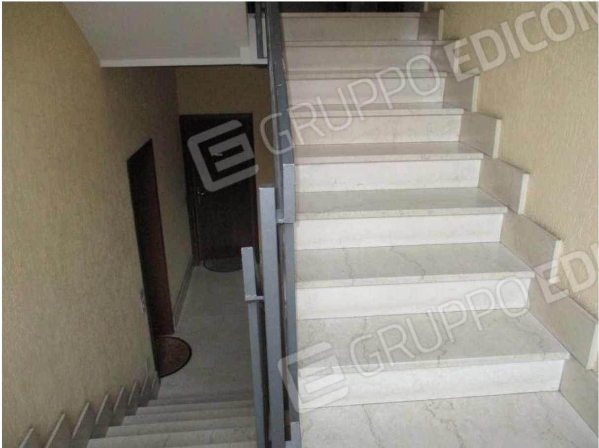
Fig. 16 – Vista del vano scala della palazzina B in cui si trova l'alloggio oggetto di stima
