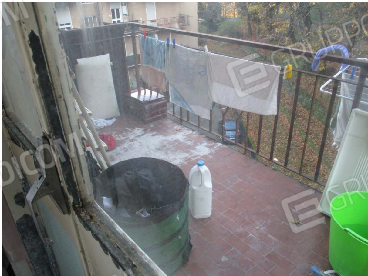
Fig. 32 – Vista del balcone con accesso dalla seconda camera
