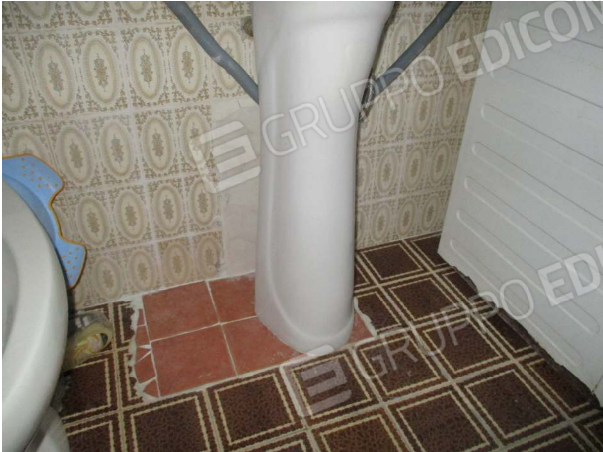
Fig. 35 – Vista delle piastrelle sostituite nel bagno
