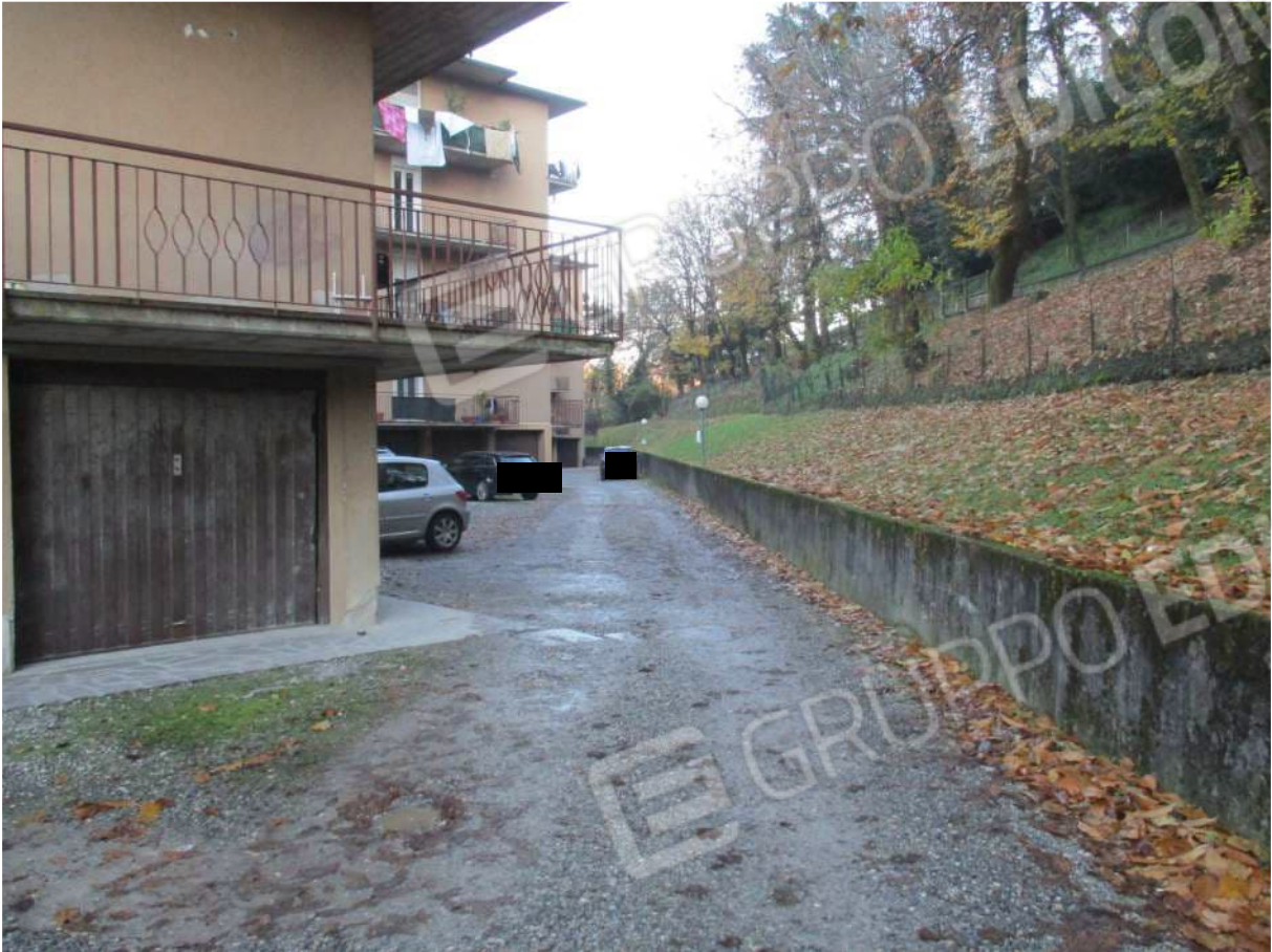
Fig. 11 – Vista del cortile comune posto sul retro del complesso (lato ovest)
