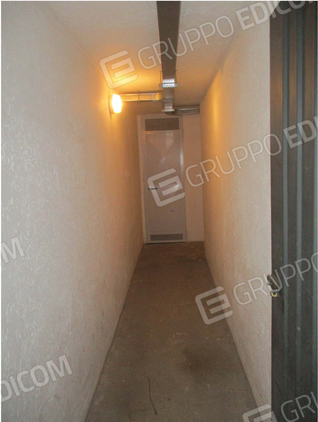
Fig. 38 – Vista del corridoio comune che conduce alle cantine di pertinenza al P. seminterrato
