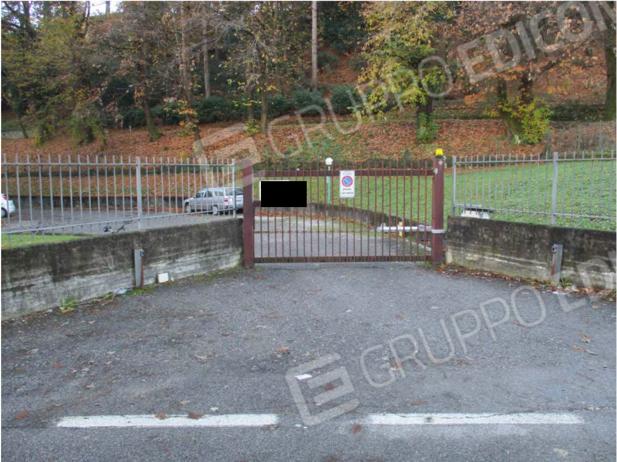
Fig. 9 – Vista dell'accesso carrale al complesso posto su Via Napoleonica
