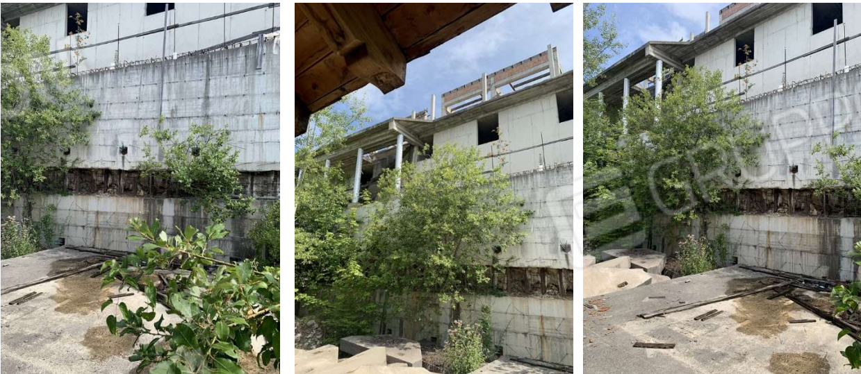
VISTE SUD DEL CORPO DI FABBRICA A MONTE
