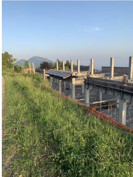
Area di cantiere-Edificio nord
