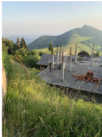
Area di cantiere-lato nord est
