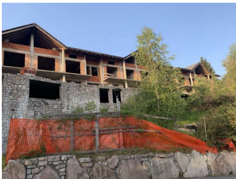
Area di cantiere-edificio sud
