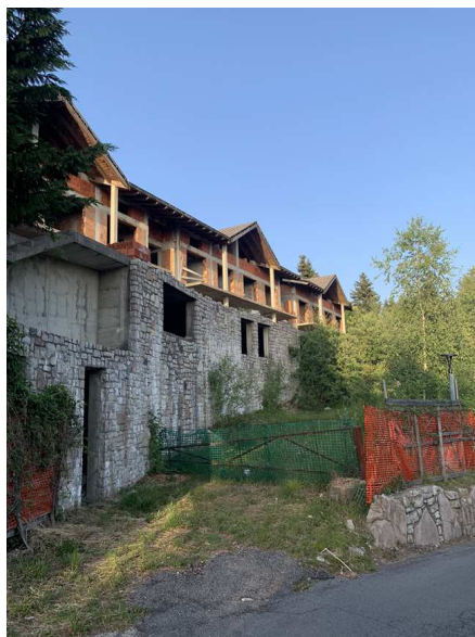
Area di cantiere-edificio sud e ingresso
