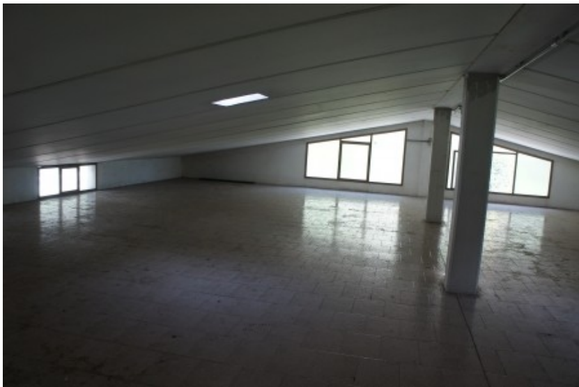
Deposito piano primo
