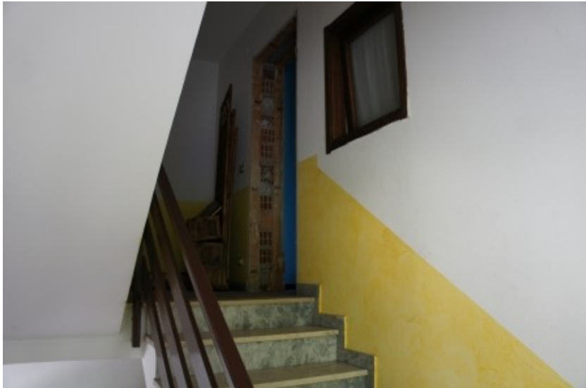
Vano scale comune
