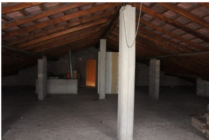
Locale deposito (sottotetto)
