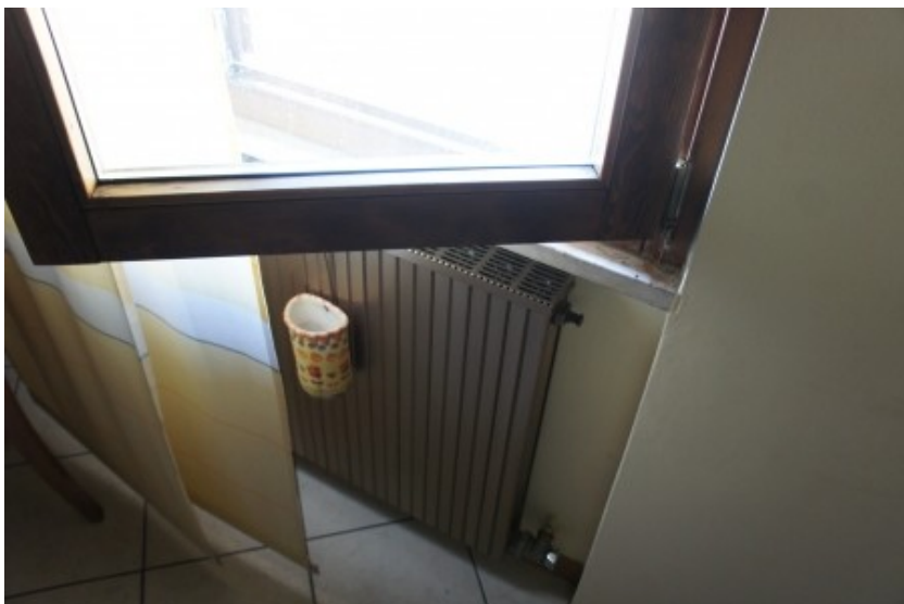
Particolare serramenti e radiatori
