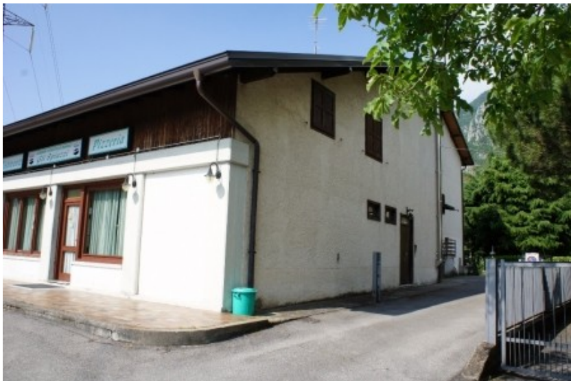
Ingresso esterno lato est
