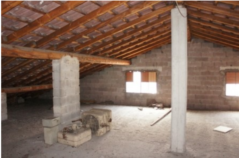
Locale deposito (sottotetto)
