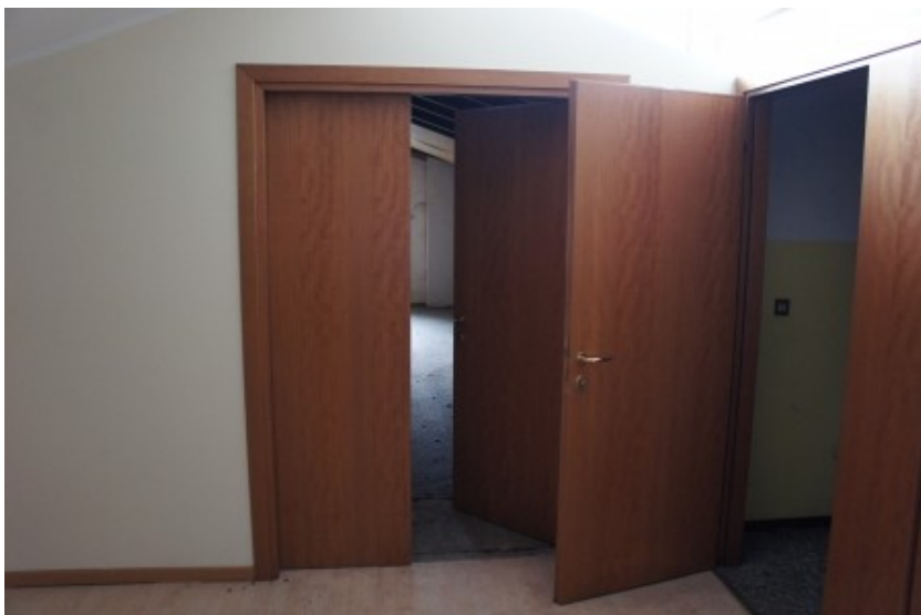
Particolare porte di accesso
