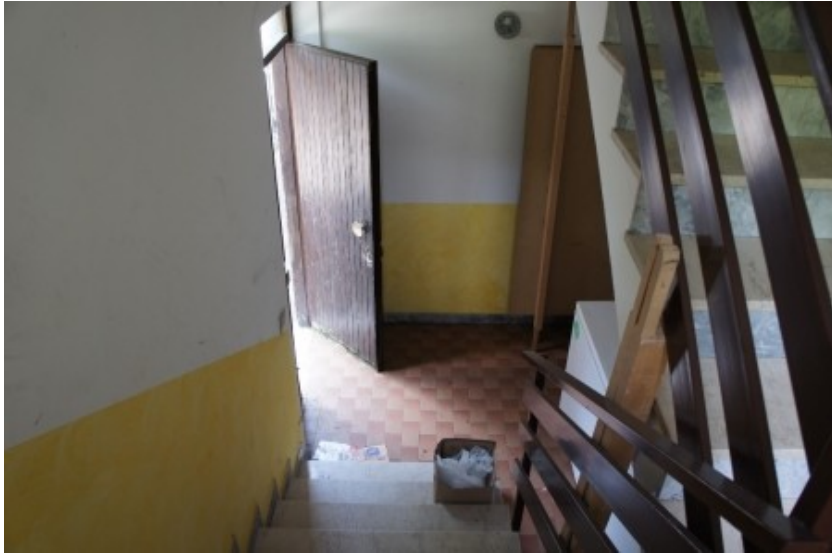
Vano scale comune
