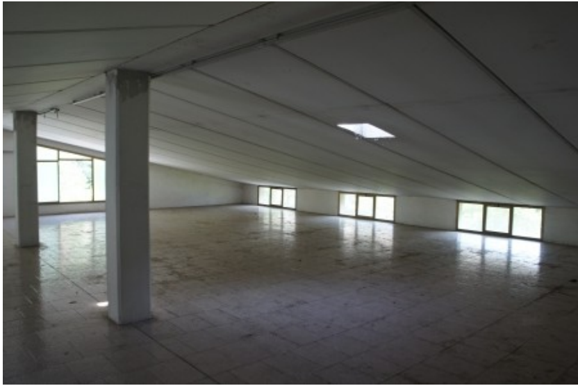
Deposito piano primo
