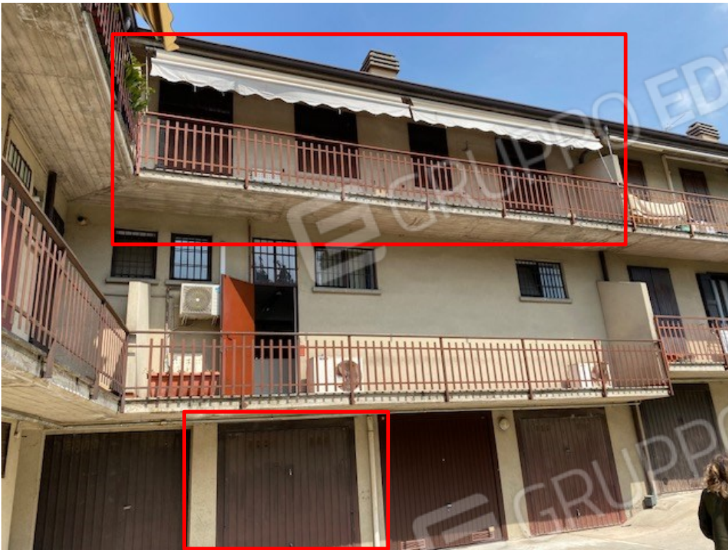
VISTA ESTERNA dal cortile interno
