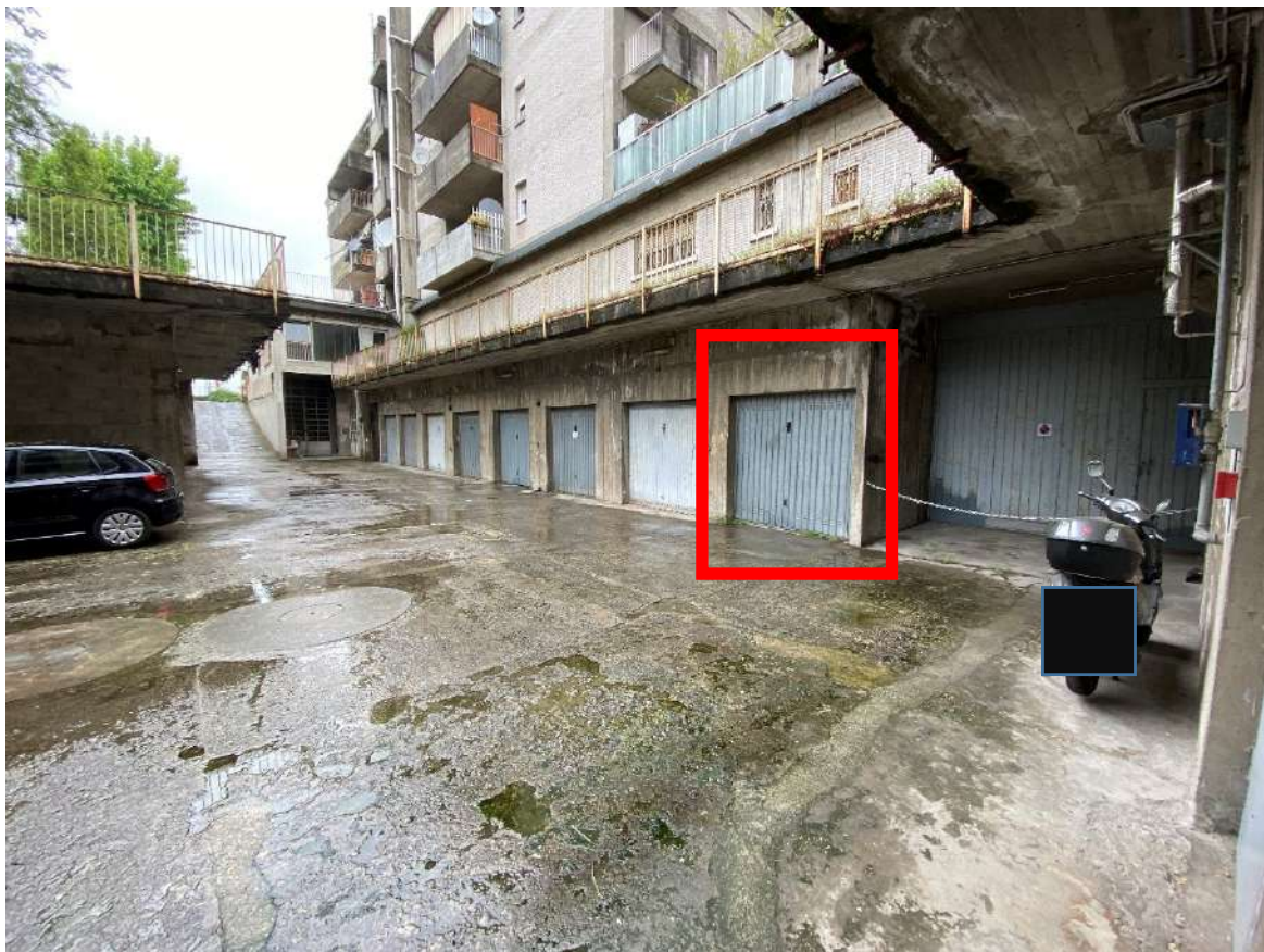
Foto 11 - Vista autorimesse P.Interrato
