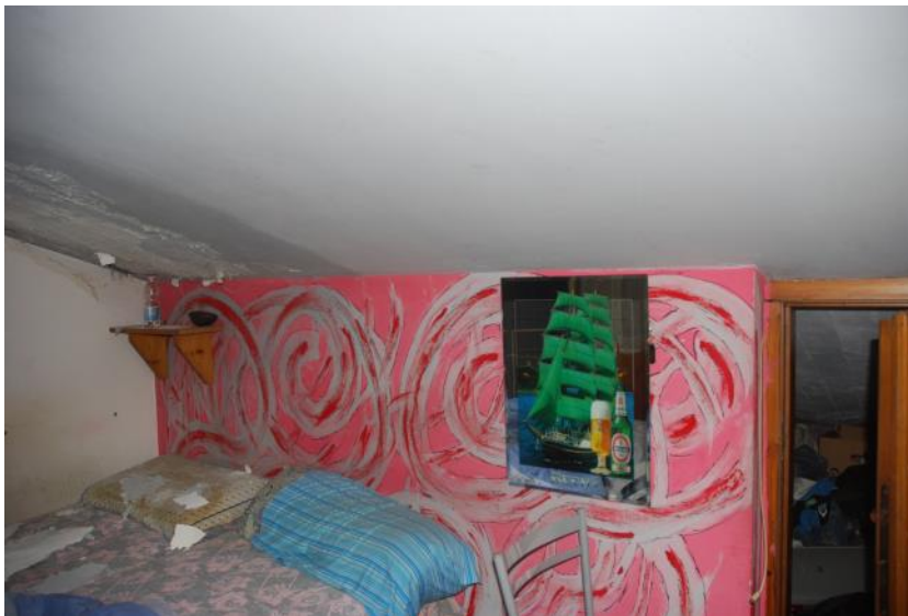
Solaio P. secondo
