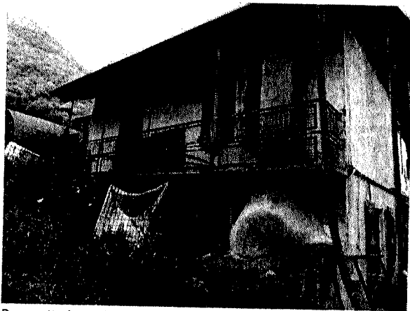
Prospetto laterale cascina
