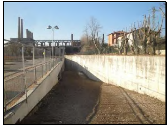
Rampa carrabile di accesso ai piani interrati
