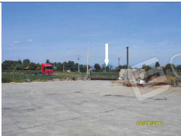
Unico accesso al compendio immobiliare
