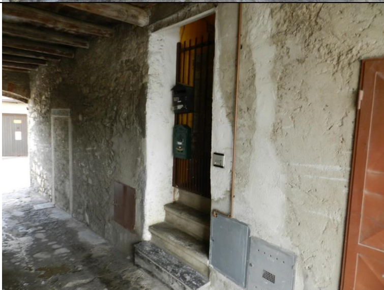
6) Nell'ambito comune troviamo la scala di ingresso, sempre comune, che porta ai piani superiori e quindi all'unità immobiliare in esecuzione
